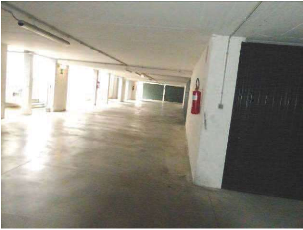
FOTO 12 - Area di manovra piano interrato
