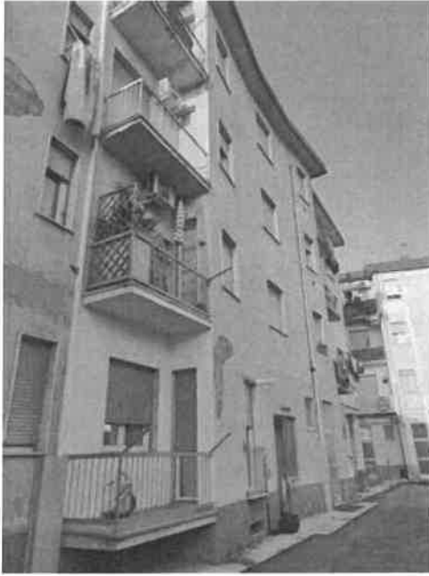
PROSPETTO SU CORTILE INTERNO
