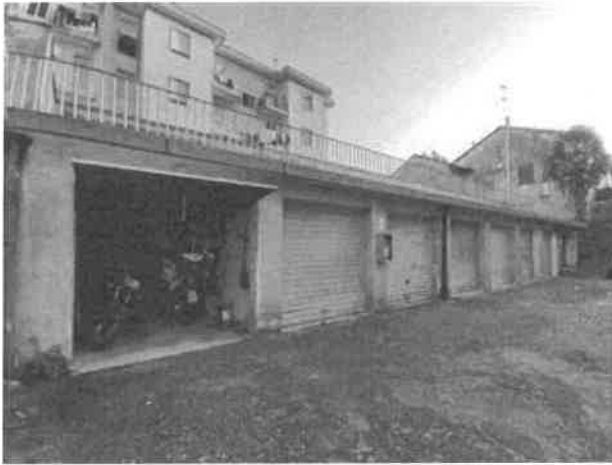
vista generale del corpo autorimesse
