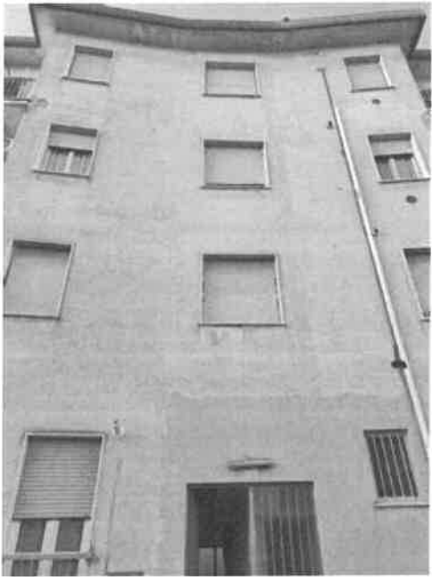
PARTICOLARE PROSPETTO SU CORTILE INTERNO
