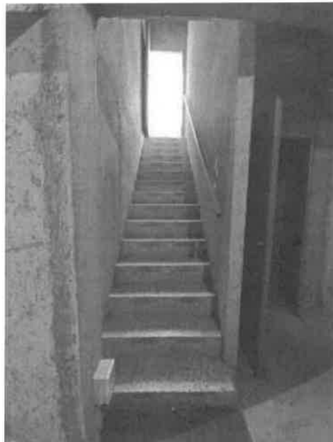
Vista scala piano cantinato
