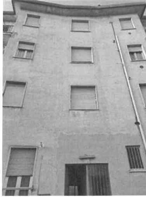
PARTICOLARE PROSPETTO SU CORTILE INTERNO
