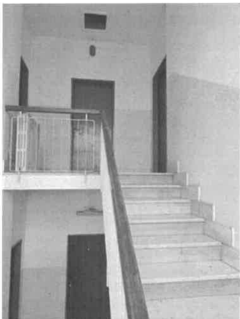
Vista vano scala (ingresso all'unità - piano terzo)
