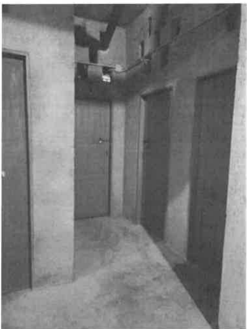
Vista disimpegno cantine
