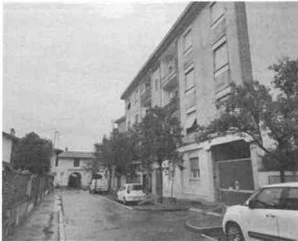
Prospetto su via Legnano con ingressi carraio e pedonale
