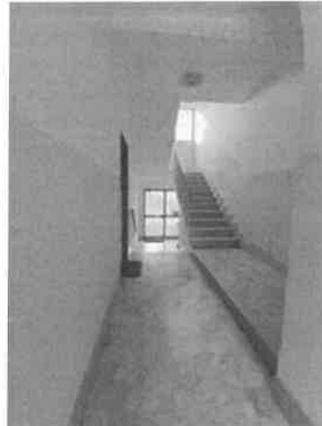
Vista vano scala (ingresso piano terra)
