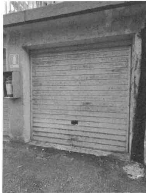
particolare esterno box
