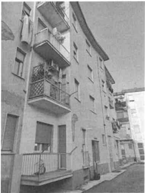
PROSPETTO SU CORTILE INTERNO
