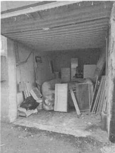
vista interna del box
