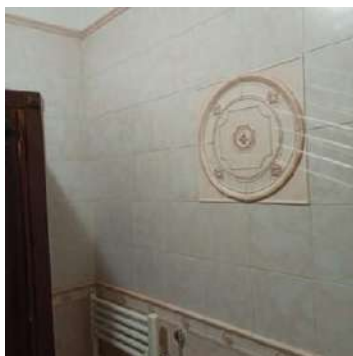
Dettaglio piastrelle del bagno e termoarredo
