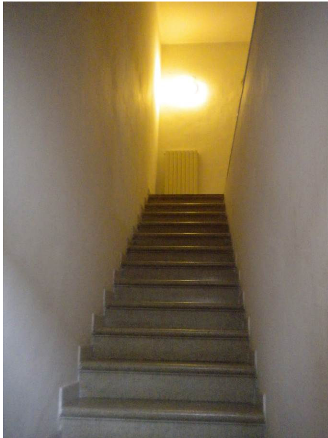
Foto 5. Scala di accesso esclusiva (vista dal P. Terra)
