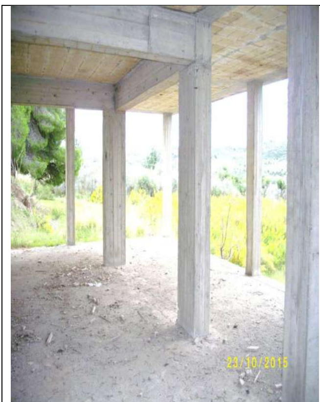
particolare del piano terra ( pilastri e soletta)
