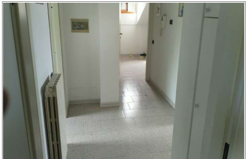
Il disimpegno del sottotetto agibile
