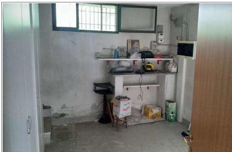
Uno dei locali del piano semi-interrato
