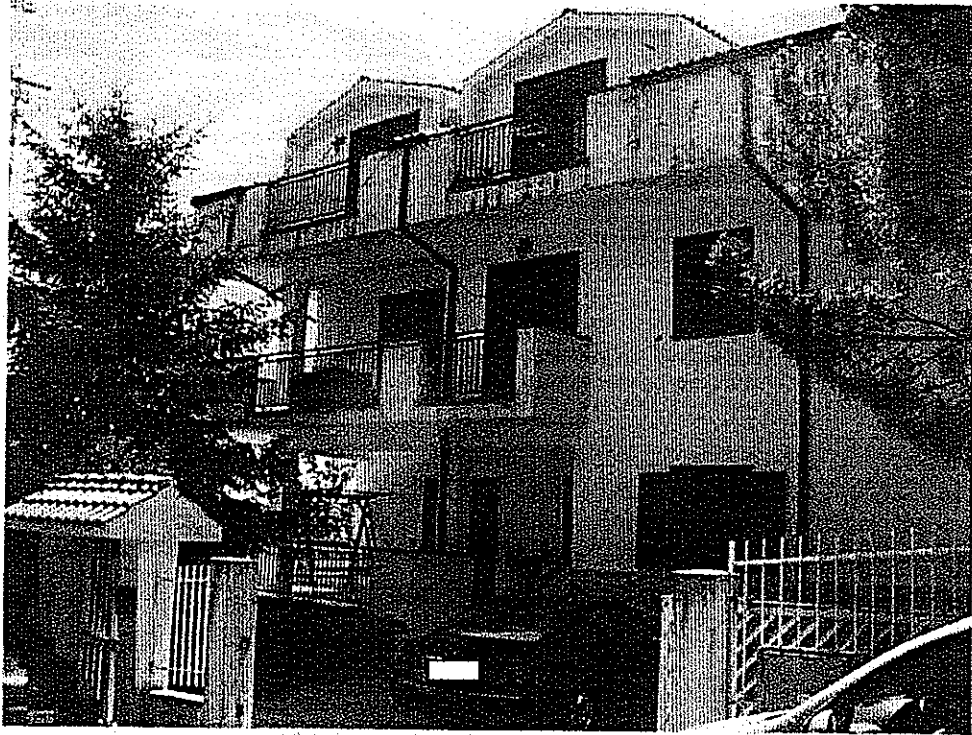
Figura 1_Fabbricato su part.Ila 266
