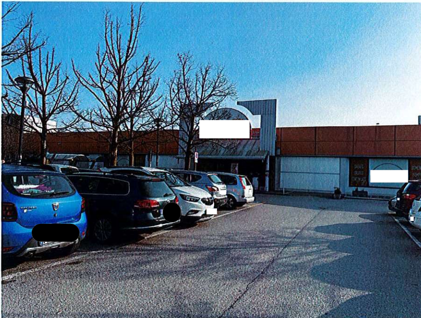
Parcheggio e Facciata Ovest fabbricato
