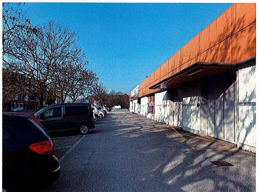
Facciata Sud fabbricato
