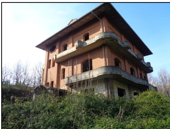
Fabbricato Prospetto SUD-EST e corte esterna
