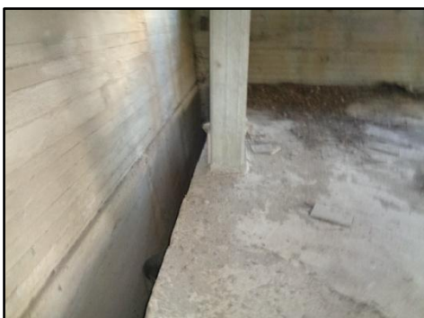
Cavedio di separazione in piano terra
