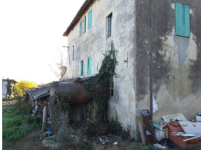
Vista laterale del portico retrostante fabbricato abitativo e servizi (sub. 2)
