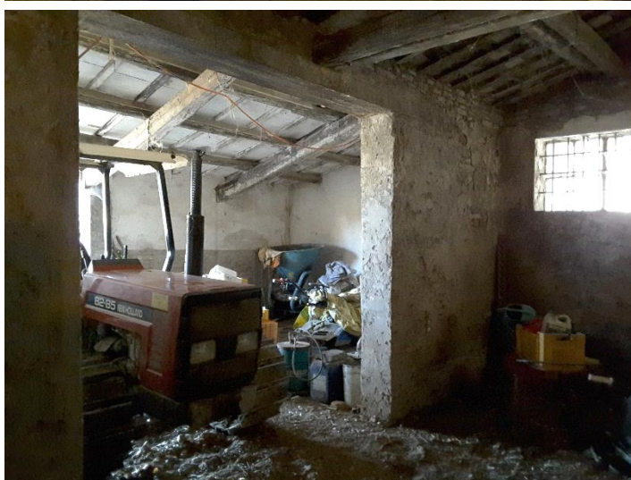
Vista interna del fabbricato sub. 2 porzione servizi
