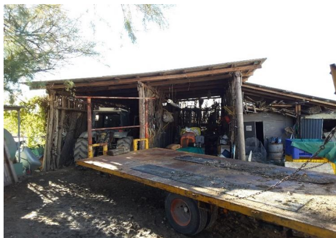
Vista del manufatto (sub.3)
