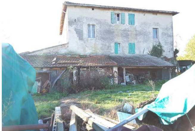
Vista frontale del portico retrostante fabbricato abitativo e servizi (sub. 2)
