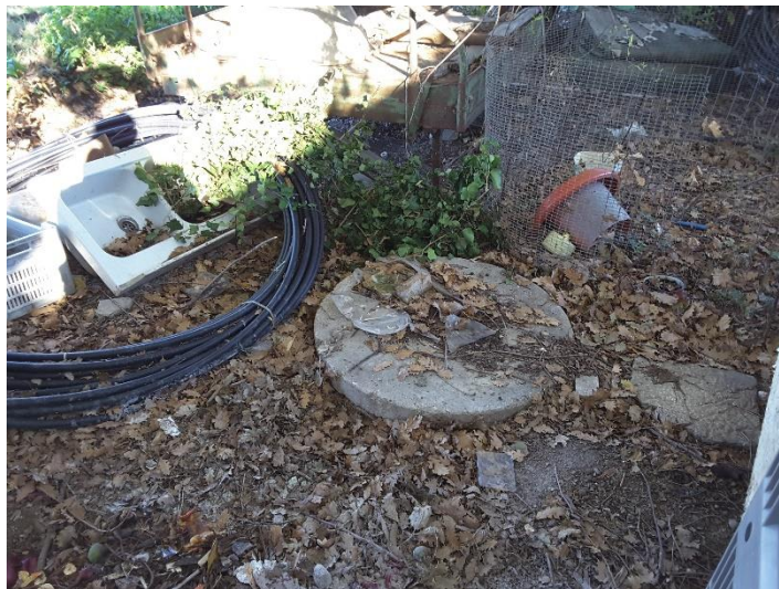
Vista della fossa Imhoff
