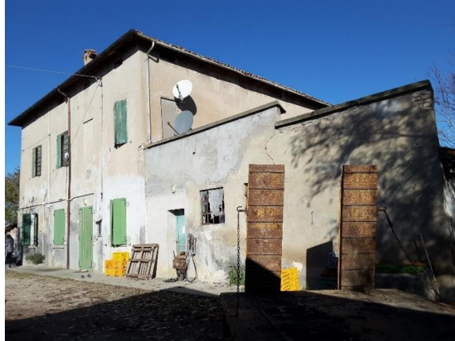
Vista laterale del fabbricato abitativo (sub. 2)
