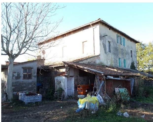
Vista laterale del fabbricato abitativo (sub. 2)
