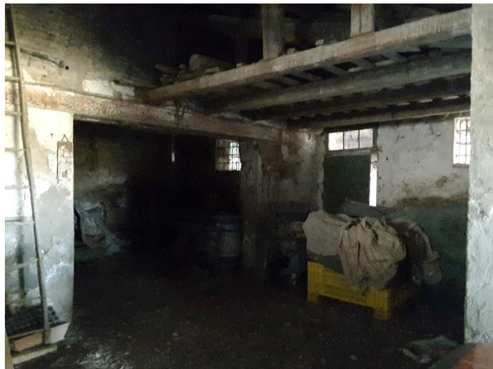
Vista interna del fabbricato sub. 2 porzione servizi
