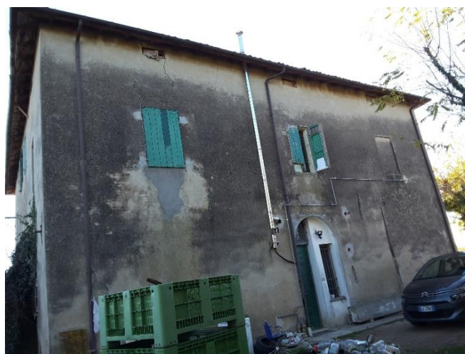
Vista laterale del fabbricato abitativo e servizi (part. 278)
