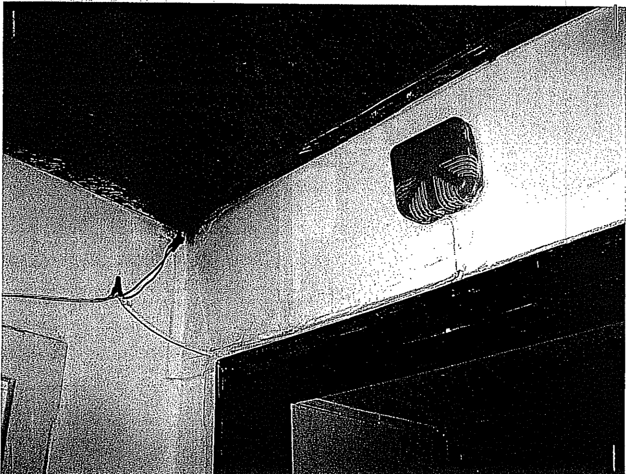
FOTO N°9 e N°10: SECONDO LOTTO, particolare dell'impianto elettrico con fili esterni non a norma.
