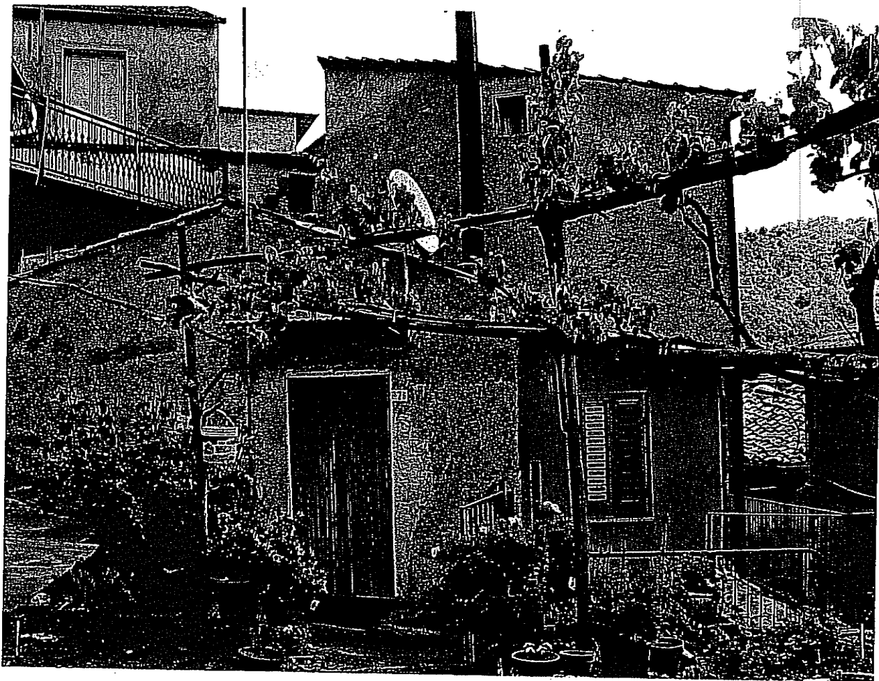
FOTO N°13: Ingresso secondario del lotto n°3 situato su di un piano rialzato e con cortile antistante in comune al lotto n°1.
