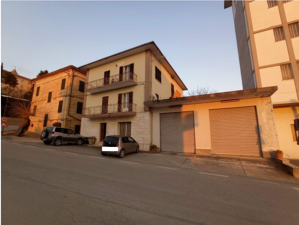
Vista Ingresso Fabbricato
