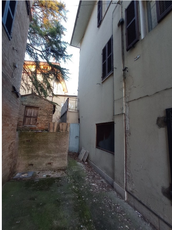
Vista facciata nord - vicolo
