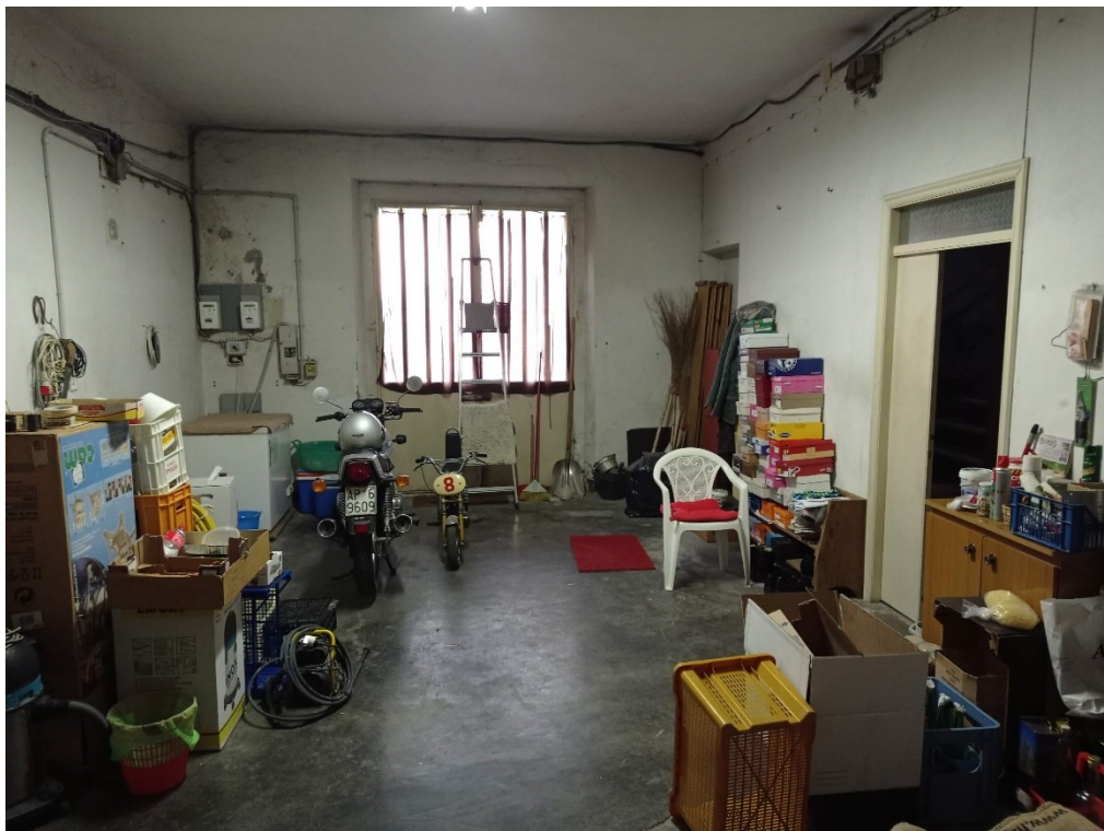
Interno locale garage – vista ingresso e contatori
