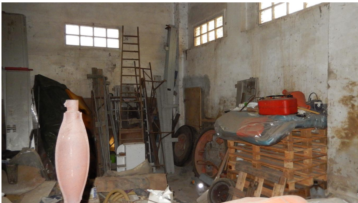
VISTA INTERNA VERSO PORTA WC (ANGOLO NORD/OVEST)
