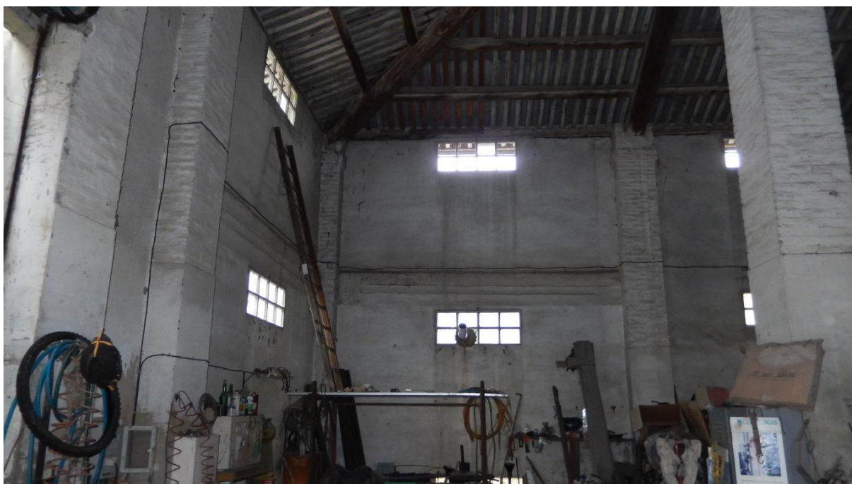
INTERNO MAGAZZINO (OPEN – SPACE)
