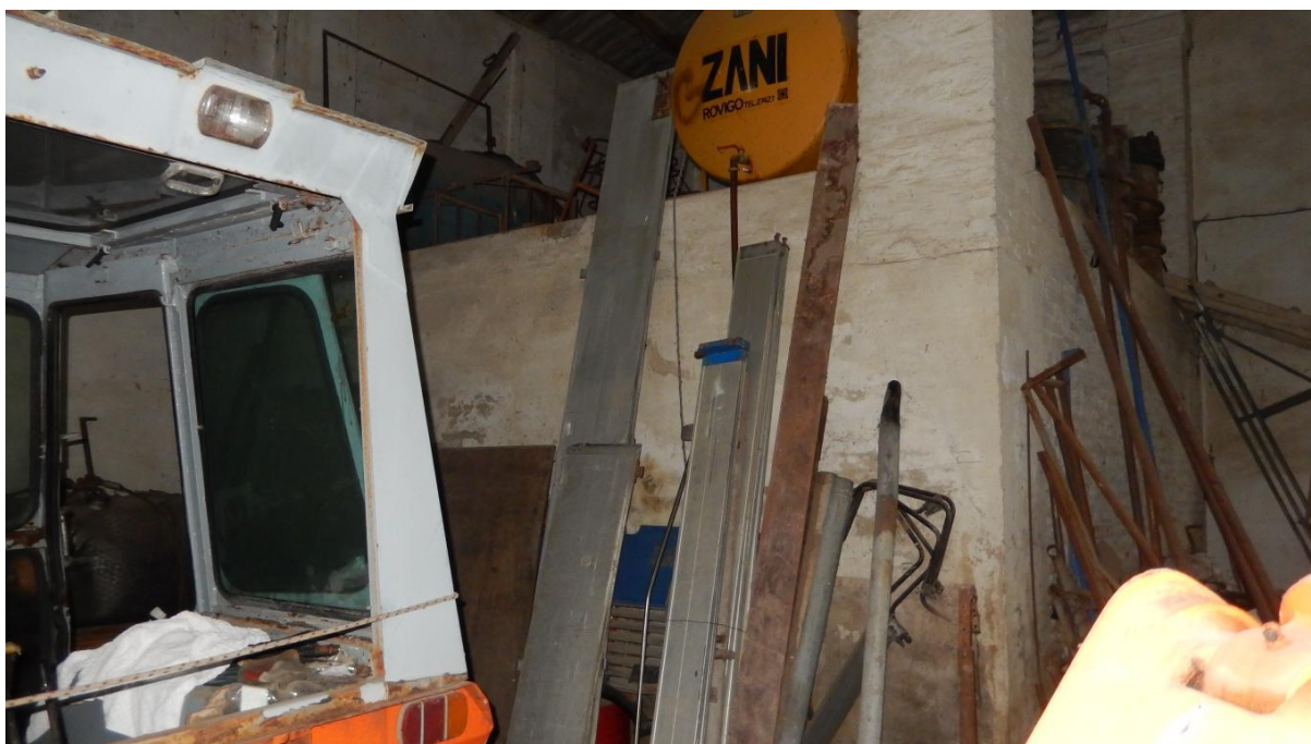
PARTICOLARE LOCALE CANTINA / DEPOSITO INTERNO MAGAZZINO
