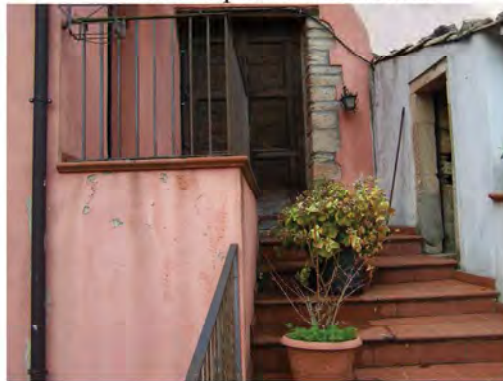
Accesso al piano sottostrada
