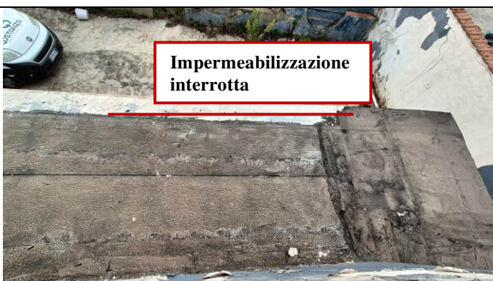
FOTO 39, 40 e 41 – Scadente sistema di impermeabilizzazione pensilina
