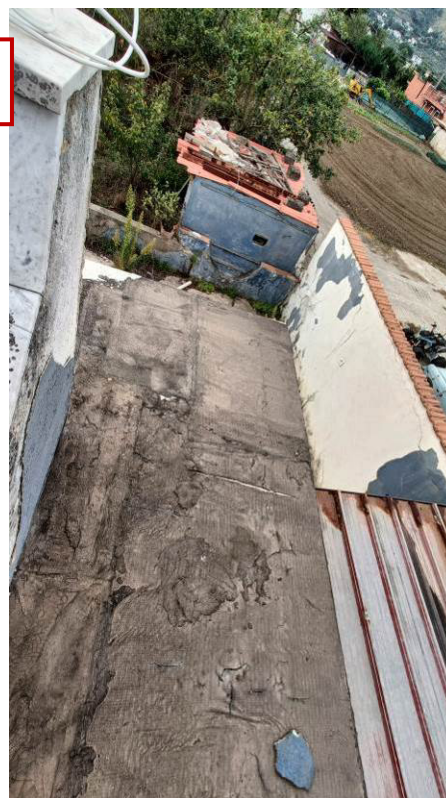
FOTO 39, 40 e 41 – Scadente sistema di impermeabilizzazione pensilina
