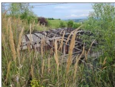
FOTO 19 - Vista del piano seminterrato in costruzione
