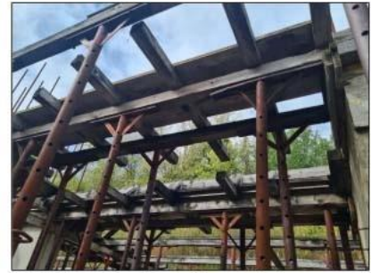
FOTO 24 - Predisposizione per solaio soprastante piano semint.
