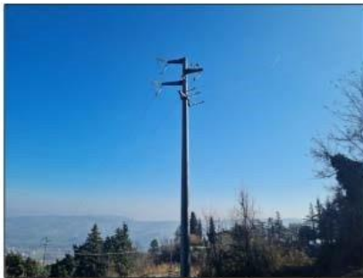
FOTO 8 - Palo della luce da spostare ed interrare
