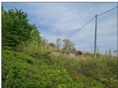
FOTO 13 - Vista laterale della linea enel da spostare/interrare
