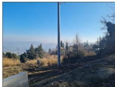
FOTO 6 - Varco sulla proprietà dalla strada di accesso
