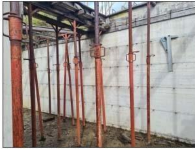
FOTO 22 - Pareti laterali del piano seminterrato
