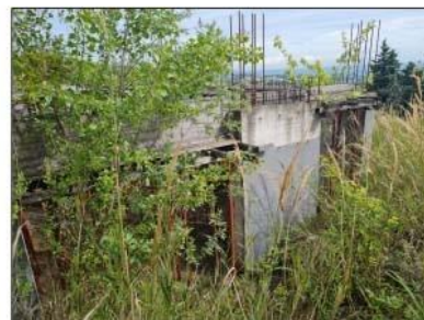
FOTO 17 - Fabbricato in costruzione
