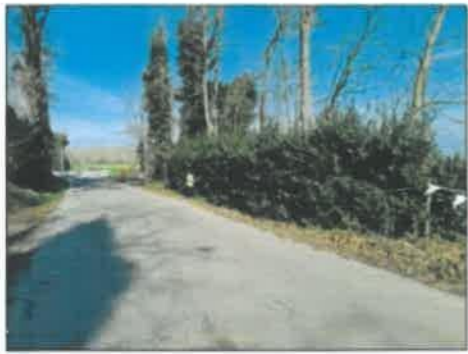
FOTO 1 - Strada di accesso
