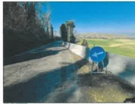
FOTO 5 - Porzione di strada messa in sicurezza
