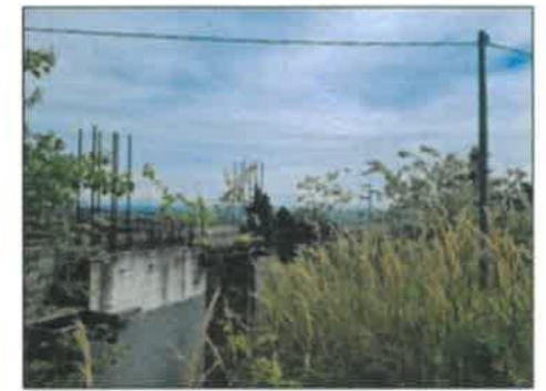
FOTO 21 - Piano seminterrato senza solaio superiore
