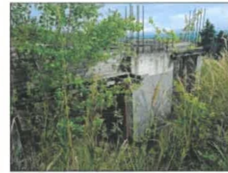
FOTO 17 - Fabbricato in costruzione
