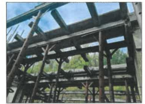
FOTO 24 - Predisposizione per solco per cemento piano semint.
