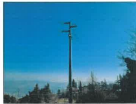
FOTO 8 - Palo della luce da spostare ed interrare
