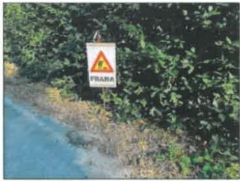
FOTO 4 - Strada soggetta a frane
