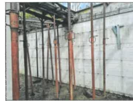
FOTO 22 - Pareti laterali del piano seminterrato
