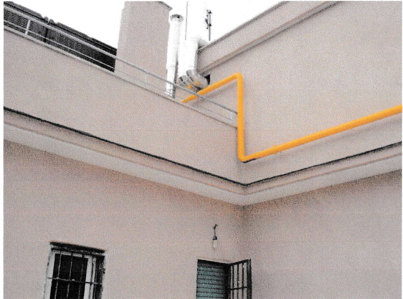
FOTO n° 26: Particolare del terrazzo di copertura soprastante in cui si intravedono i nuovi lavori, canne inox del riscaldamento e tubazione gas.
