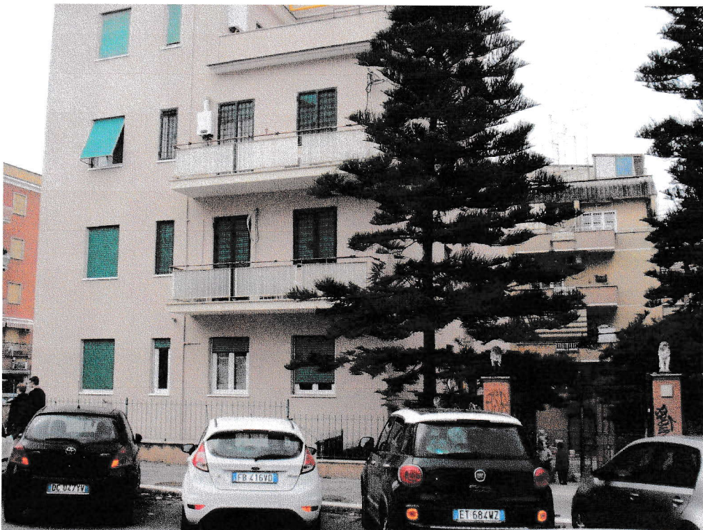
Foto n° 5 e6 : Due immagini riprese dal prospetto lato Nord, Via delle Betulle Civico n° 80.
