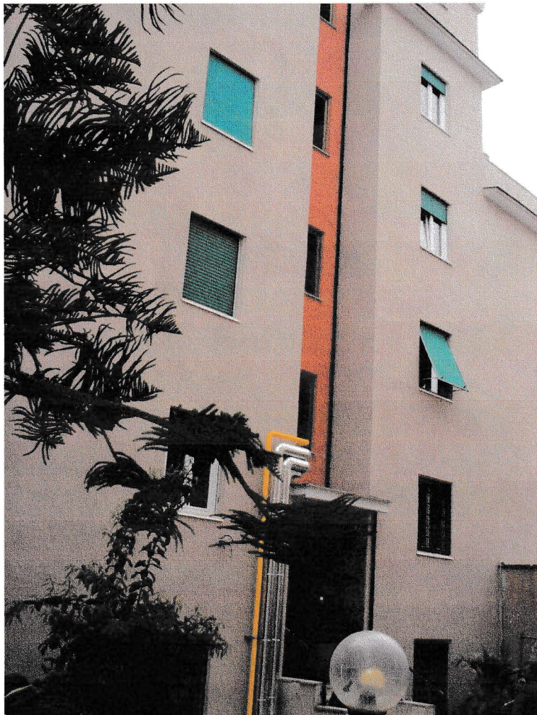
Foto n° 7 e 8 : Due immagini riprese dal prospetto lato Nord da cui si notano i lavori condominiali in corso.
