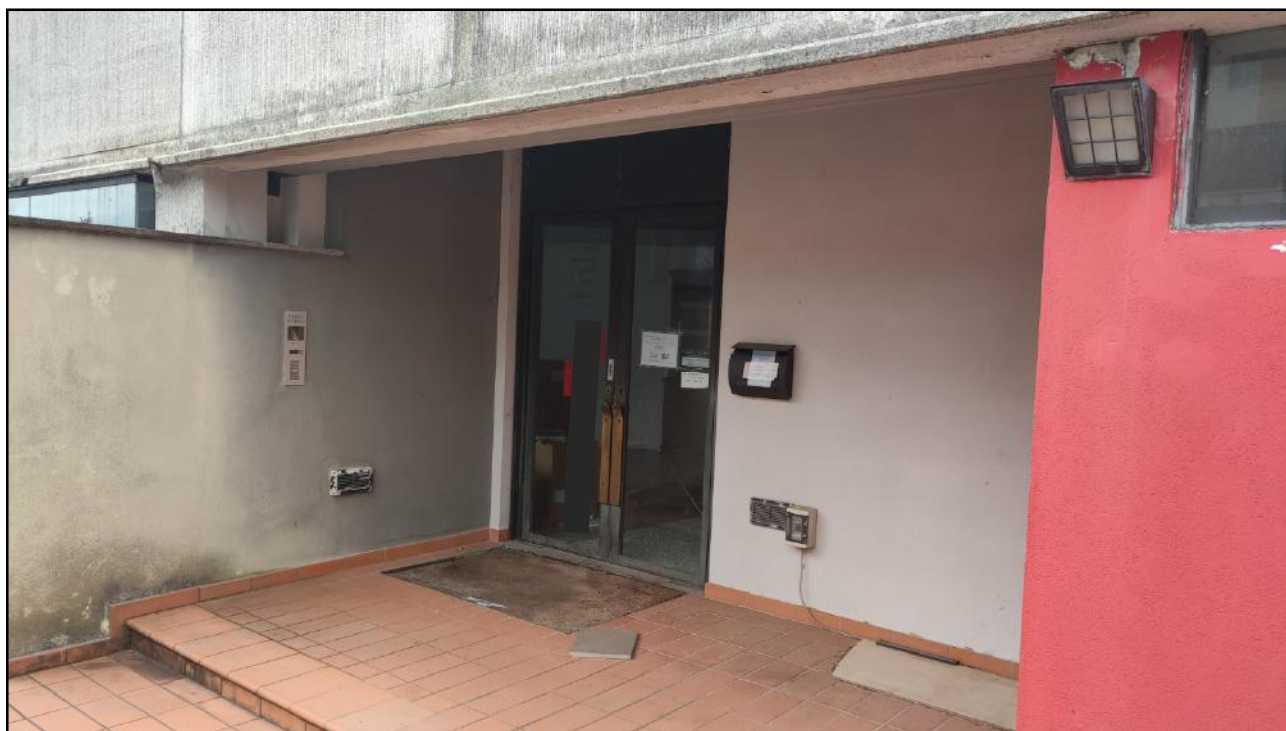
Vista Esterna - Prospetto Est – Zona Ingresso
