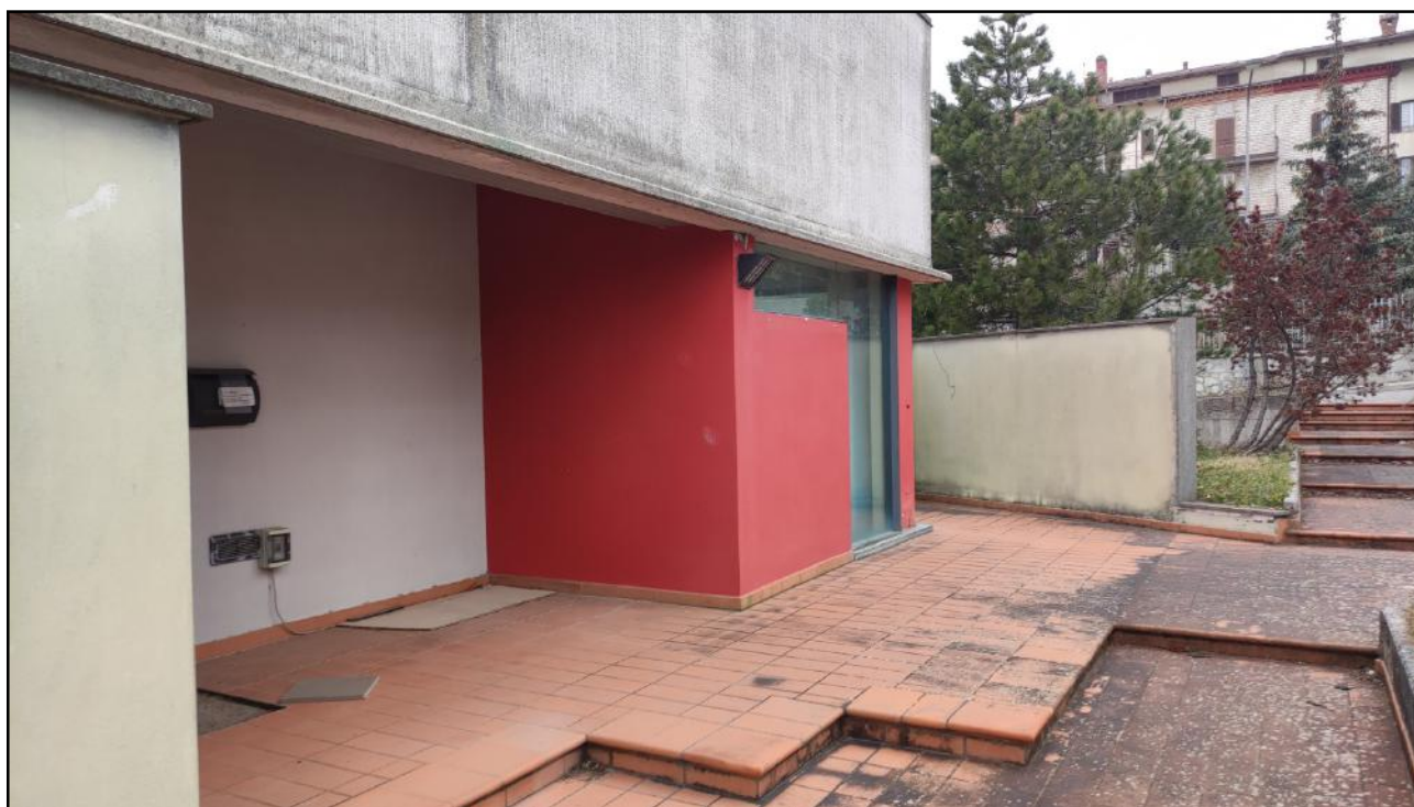
Vista Esterna - Prospetto Est – Zona Ingresso
