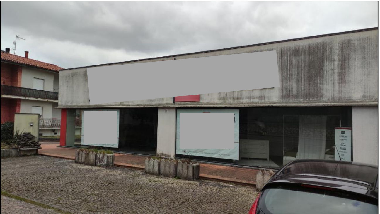
Vista Esterna - Prospetto Nord
