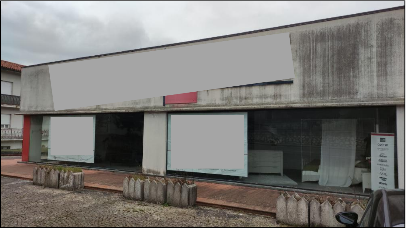
Vista Esterna - Prospetto Nord
