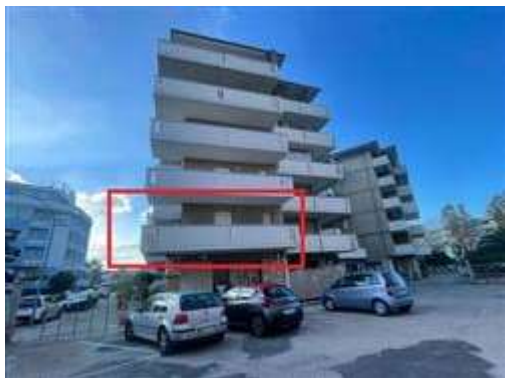
prospetto su corte condominiale
