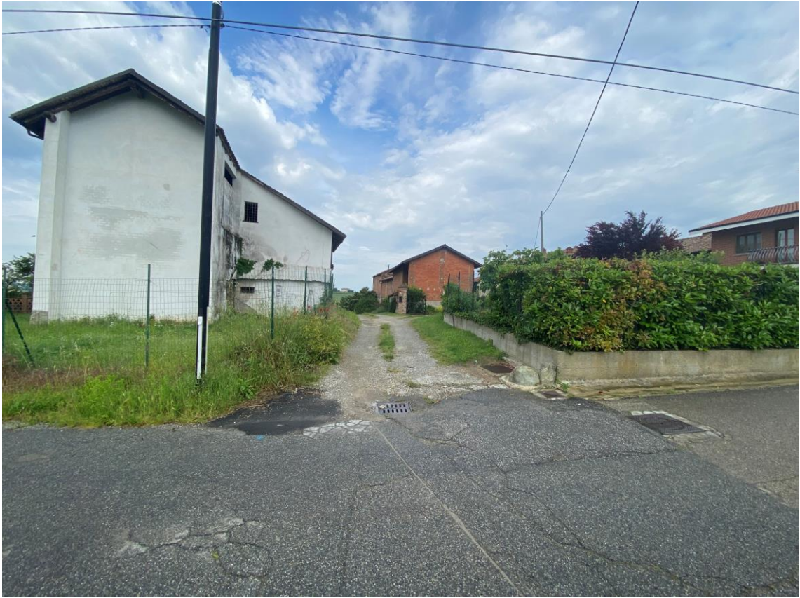
FOTO 1 Accesso dalla strada pubblica
