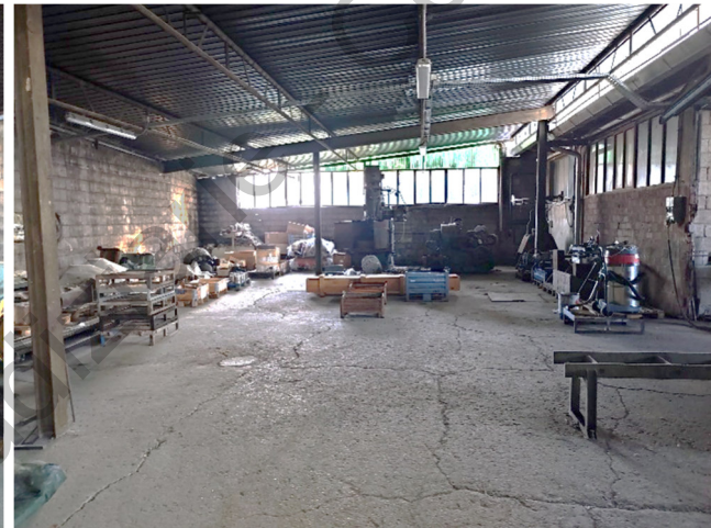
particolare interno capannone/tettoia
