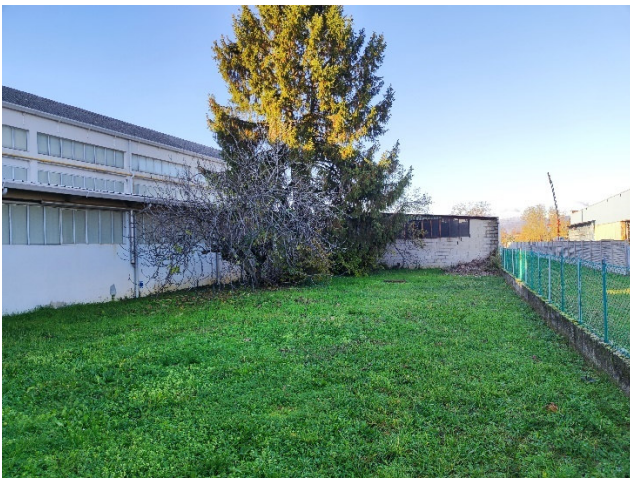
prospetto sud tettoia/capannone
