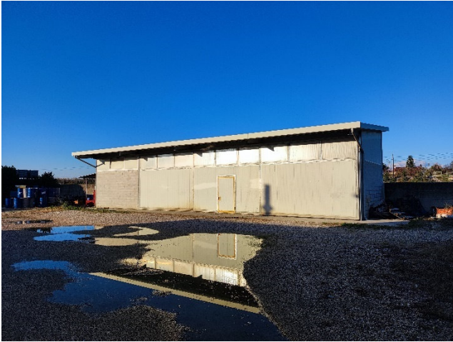
Particolare prospetto sud tettoia
