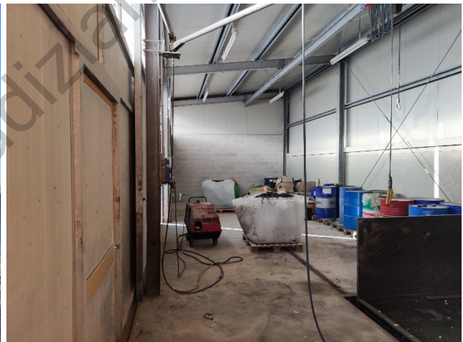
particolare interno tettoia
