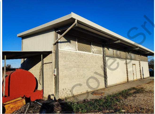
particolare prospetto sud/ovest tettoia
