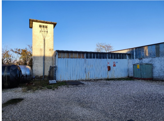
prospetto sud-est tettoia/capannone/cabina
