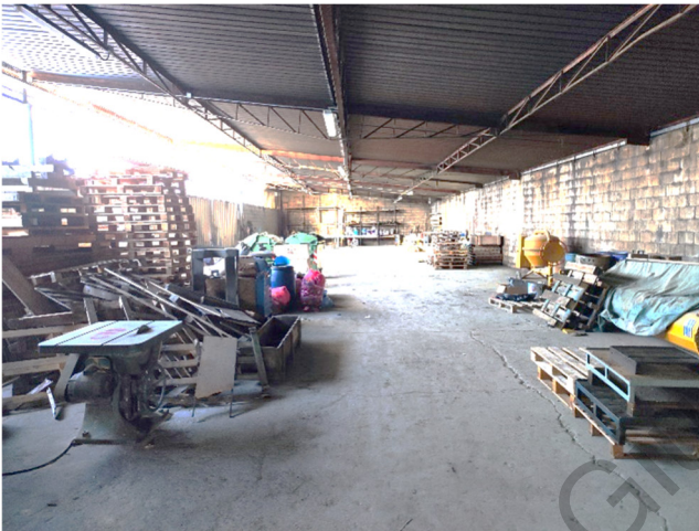
Particolare interno capannone/tettoia
