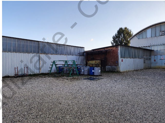
prospetto nord-ovest tettoia/capannone
