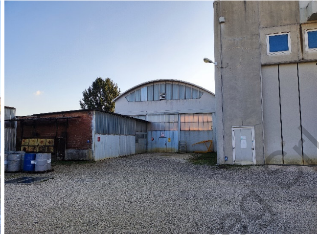
prospetto nord capannone
