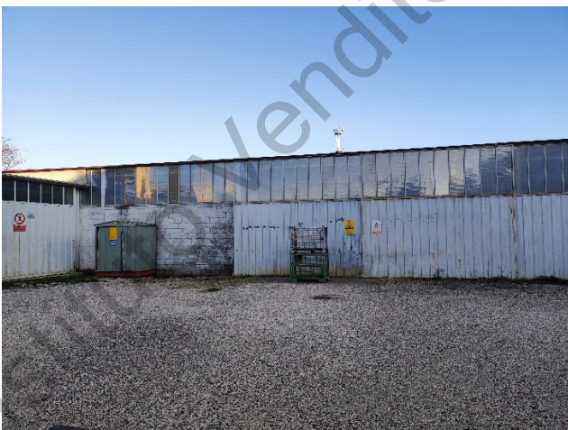
prospetto ovest tettoia/capannone
