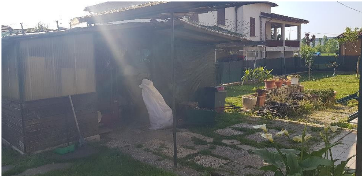
Figura 10: presenza di baraccature nel cortile lato est
