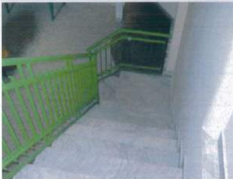
Particolare scala al vano piano seminterrato.
