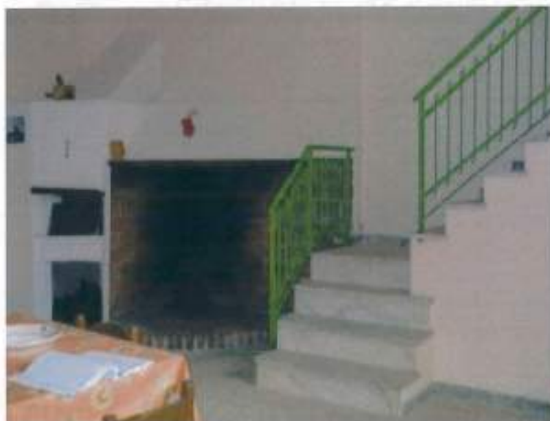
Particolare scala al vano piano seminterrato
