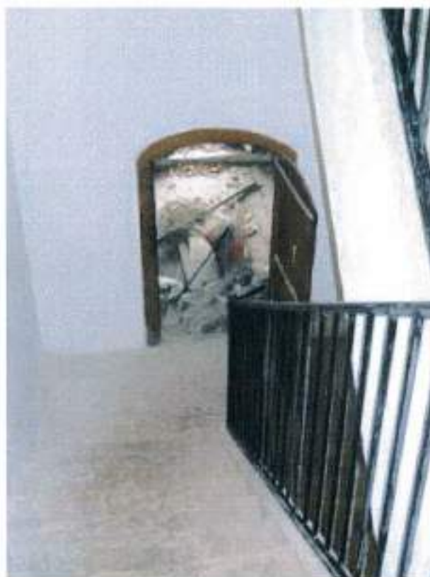
Vista corpo scala
