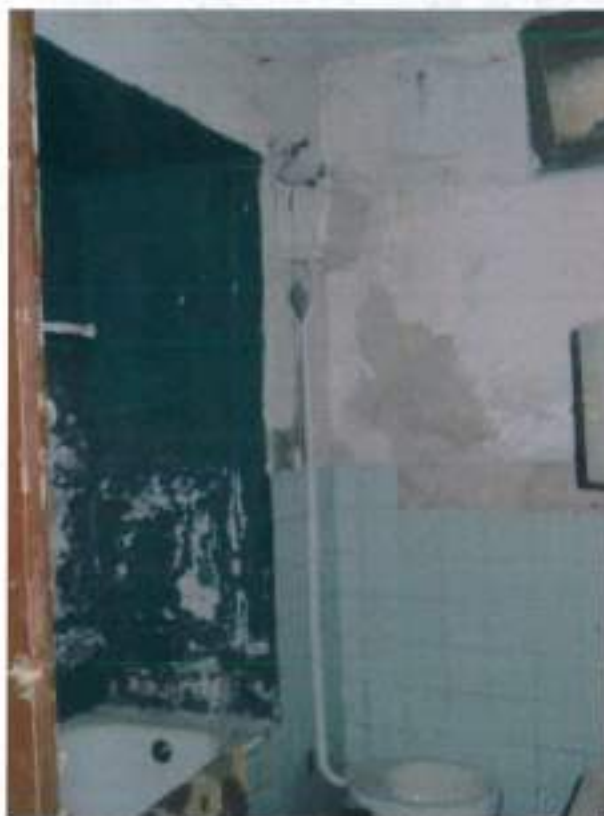
Particolare servizio igienico
