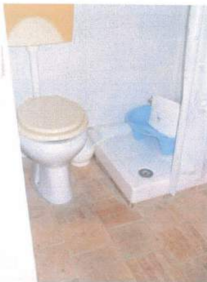
Particolare vano servizio igienico
