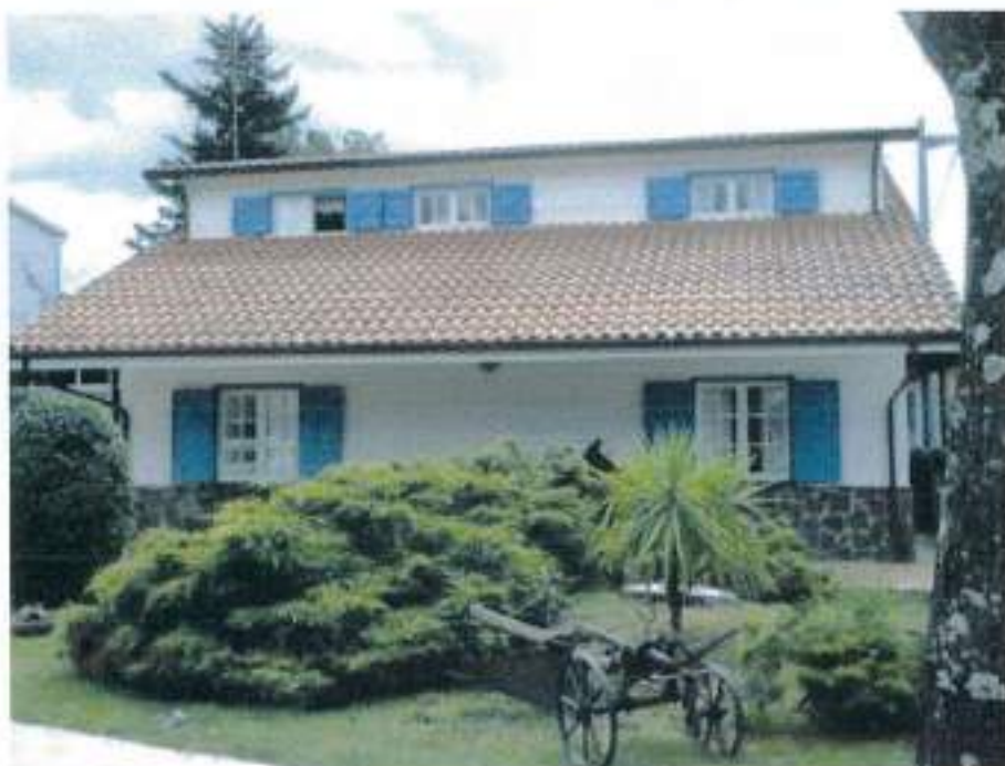
Vista prospetto principale
