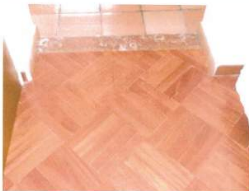
Vista particolare pavimentazione
