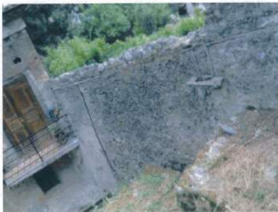
Vista muro di confine
