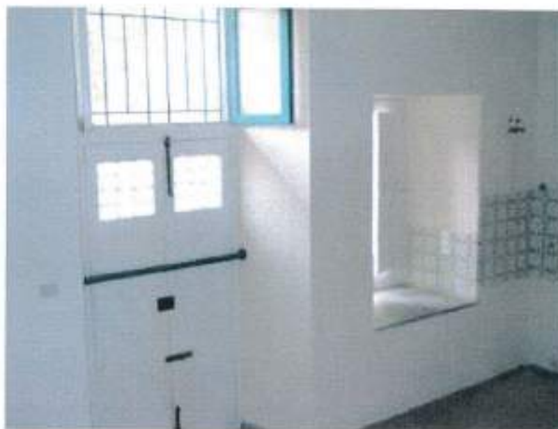
Particolare vano piano seminterrato
