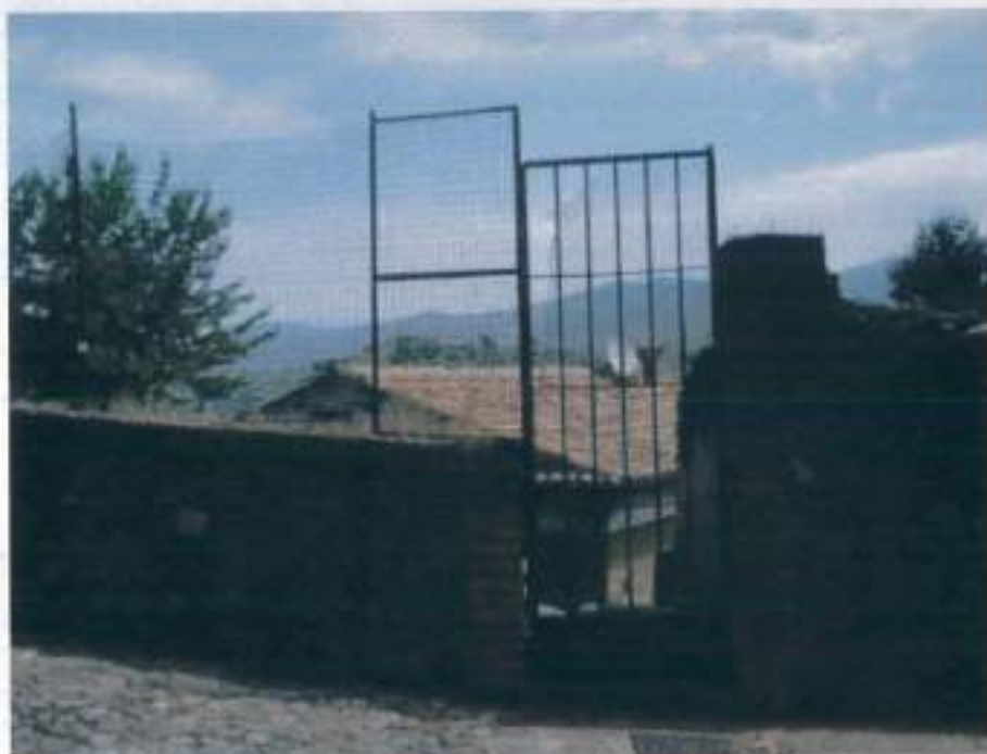
Vista ingresso da Via L. Della Valle
