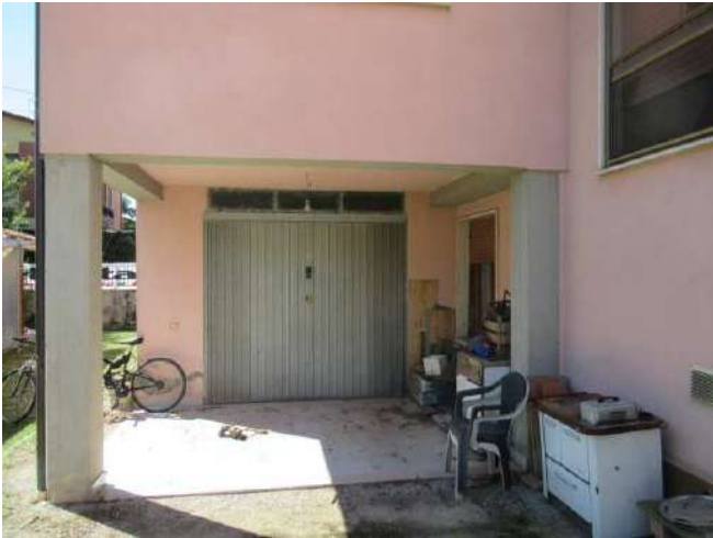
Foto n. 29: Porta d'accesso al garage
