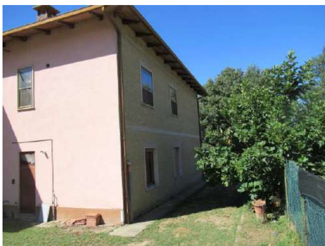
Foto n. 5: Facciata Nord del fabbricato
