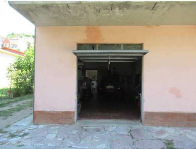
Foto n. 19: Porta d'accesso al garage
