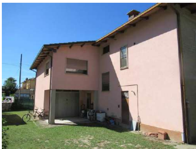
Foto n. 4: Facciata Est del fabbricato
