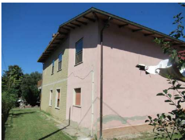
Foto n. 3: Facciata Sud del fabbricato
