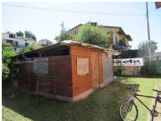
Foto n. 10: Manufatto da demolire
