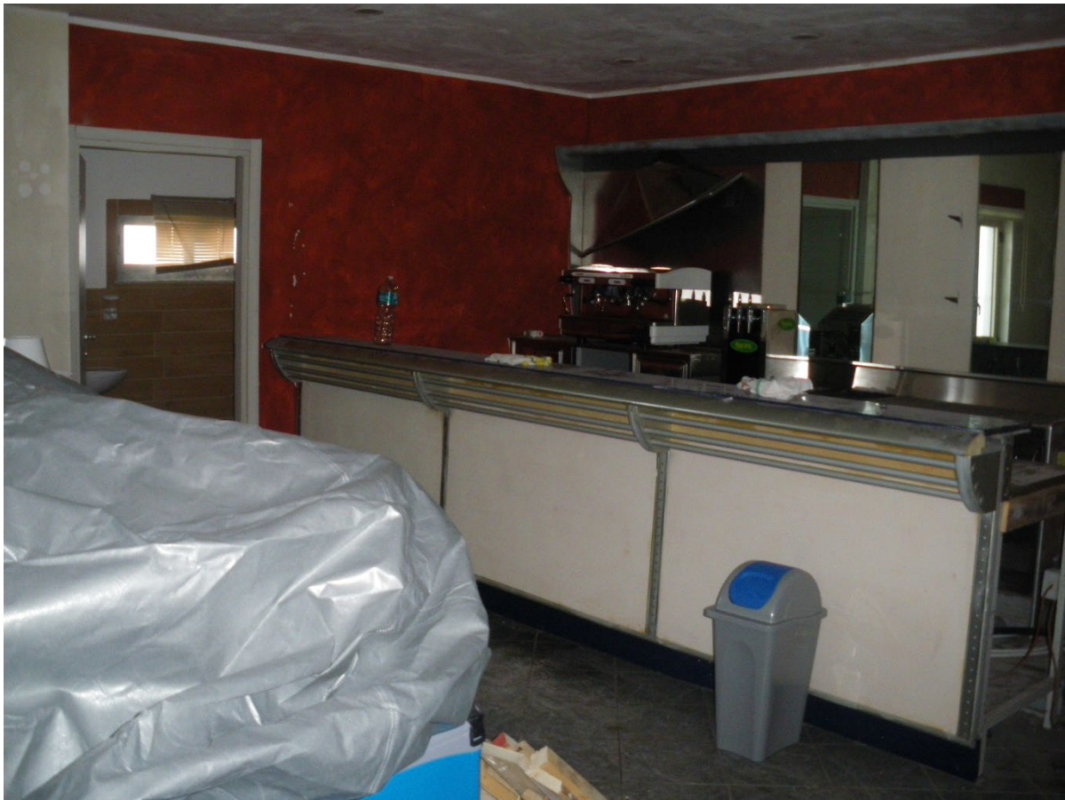
Foto n. 13: locale bar (lotto 01)
