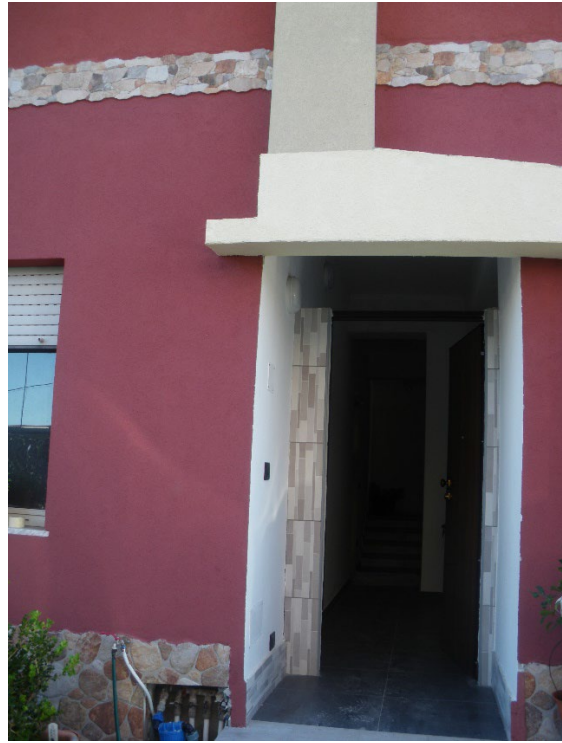
Foto n. 04: Ingresso autonomo ai locali accessori sub 4
