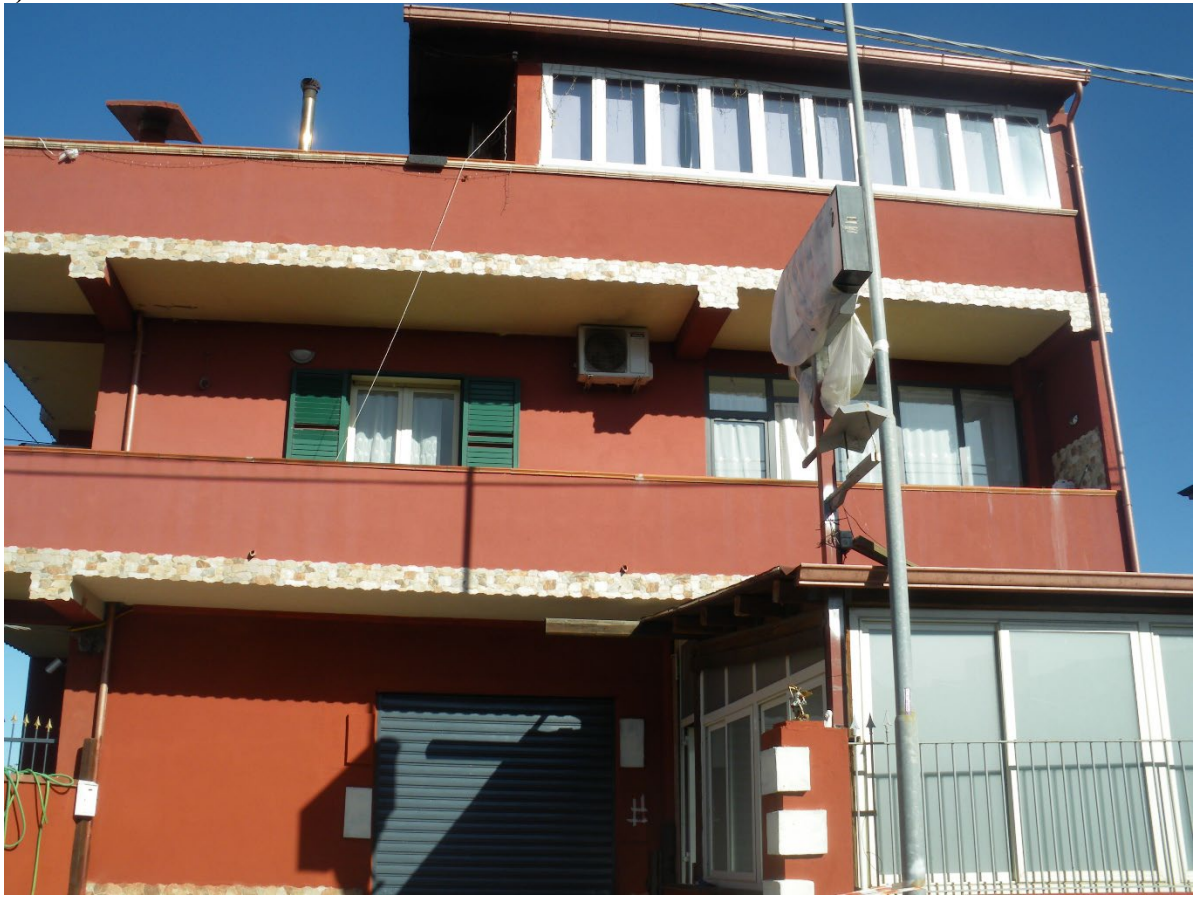
Foto n. 01: Prospetto principale del fabbricato
