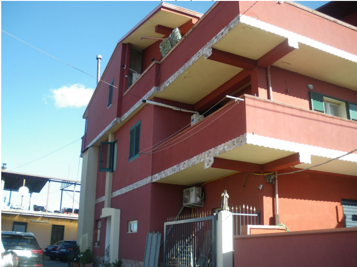
Foto n. 02: Prospetto laterale del fabbricato
