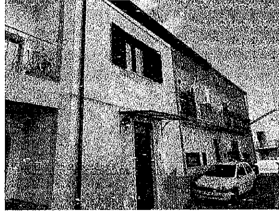
INGRESSO AL PIANO TERRA – LOTTO UNICO – Lu
