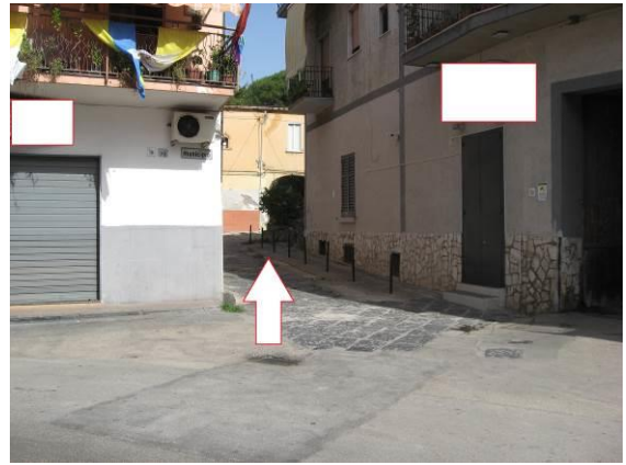
Figura 2 via Municipio in Striano con accesso al lotto pignorato
