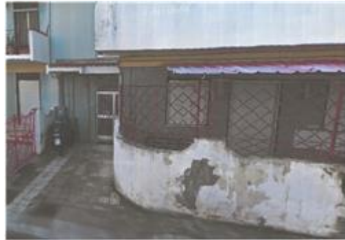
Foto n. 2 Ingresso cancello pedonale
