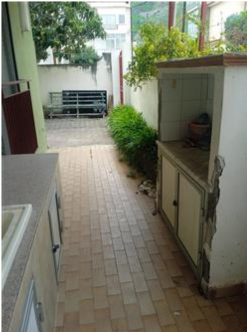
Foto n. 9 cortile lato ovest
