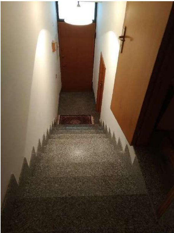
VANO 1 ( CORPO SCALA ) --- FOTO 4
