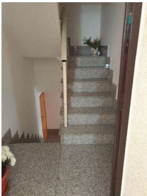
VANO 6 (CORPO SCALA) --- FOTO 18
