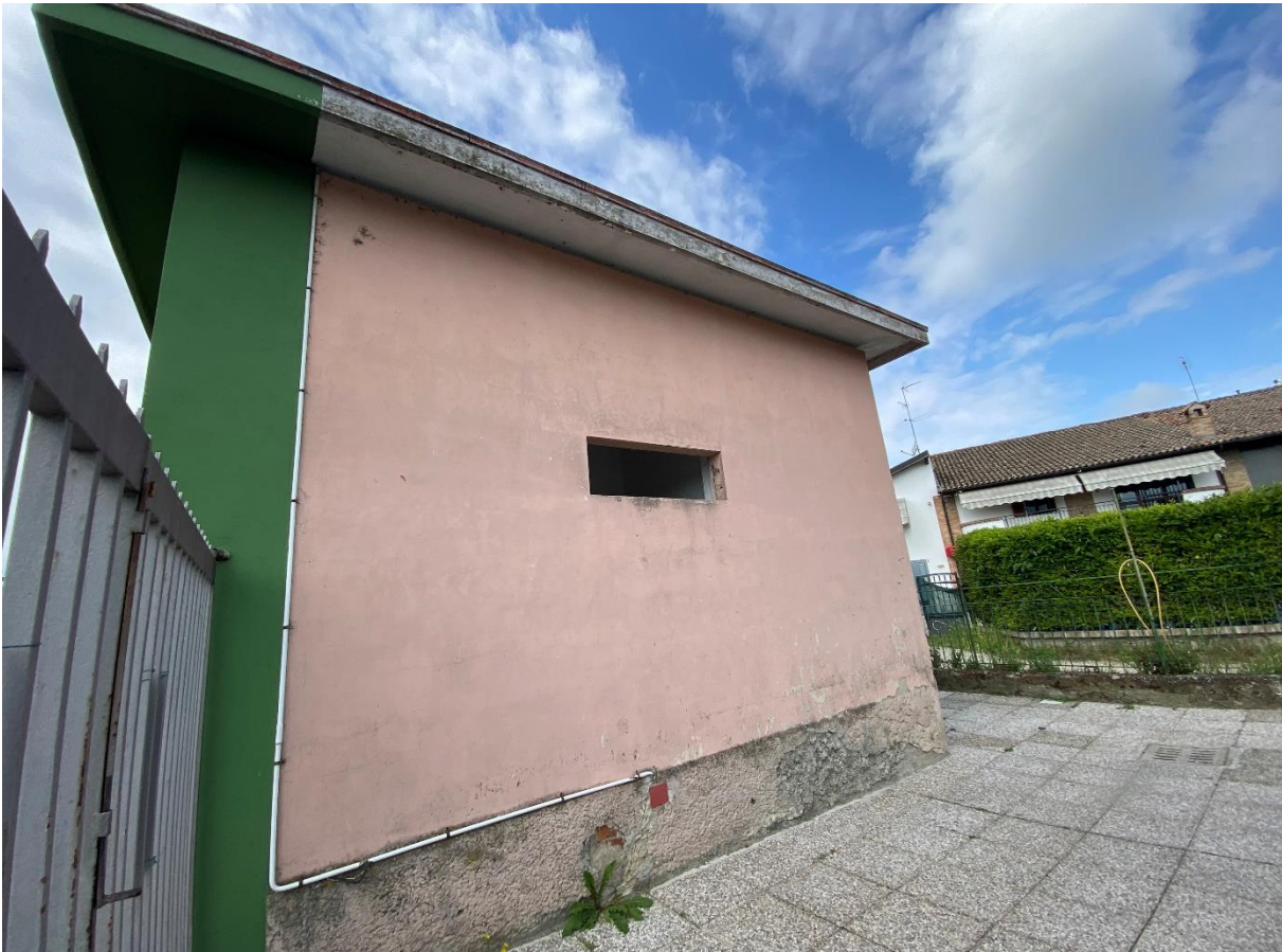
FOTO 17: facciata lato nord
