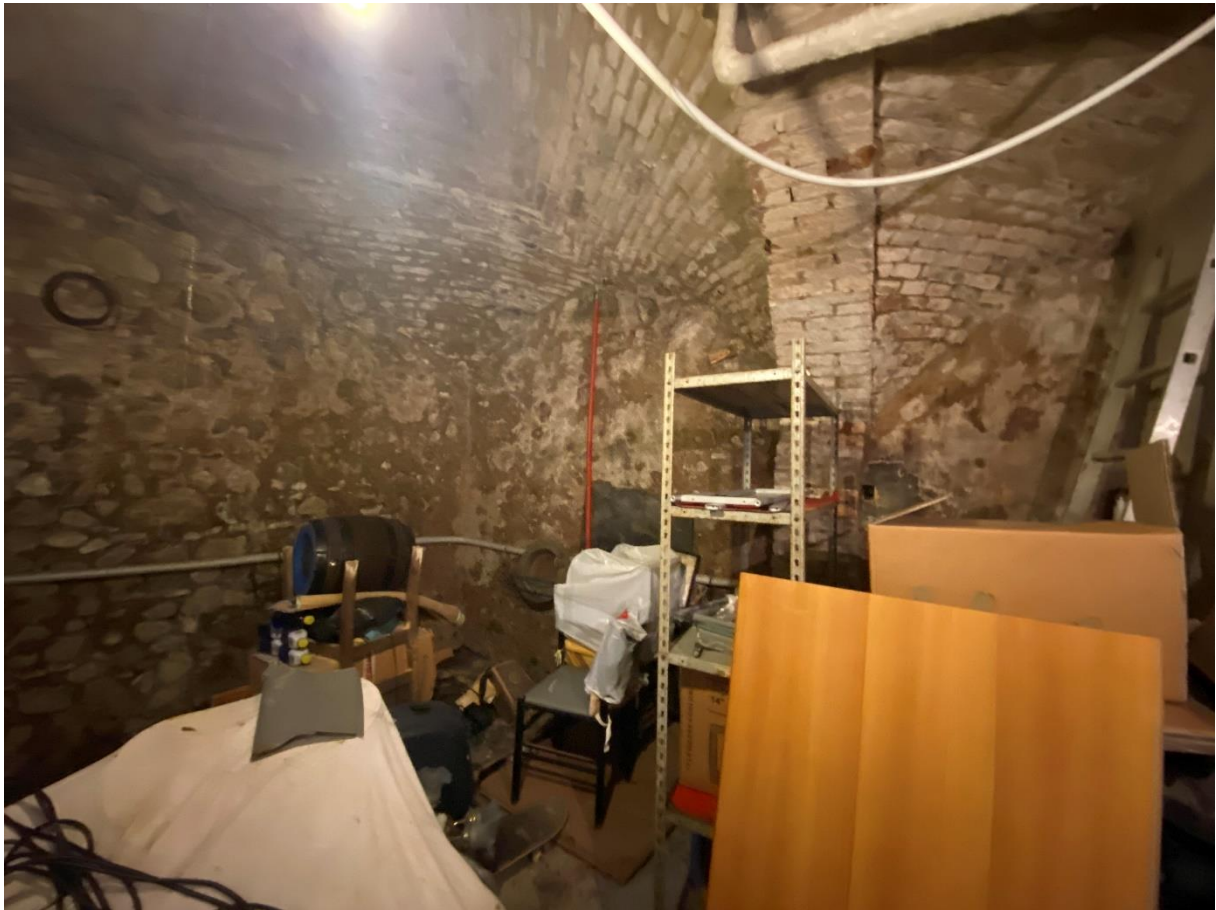
FOTO 19: cantina di pertinenza
