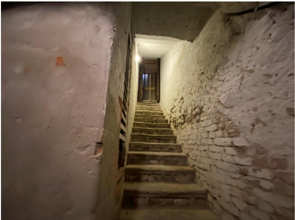
FOTO 18: scala di accesso al piano interrato
