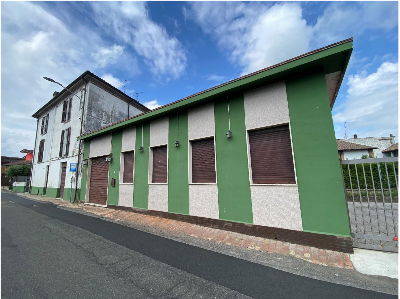
FOTO 4: prospetto fronte strada
