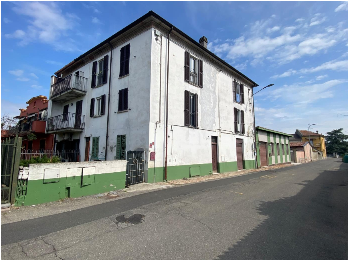
FOTO 5: prospetto fronte strada
