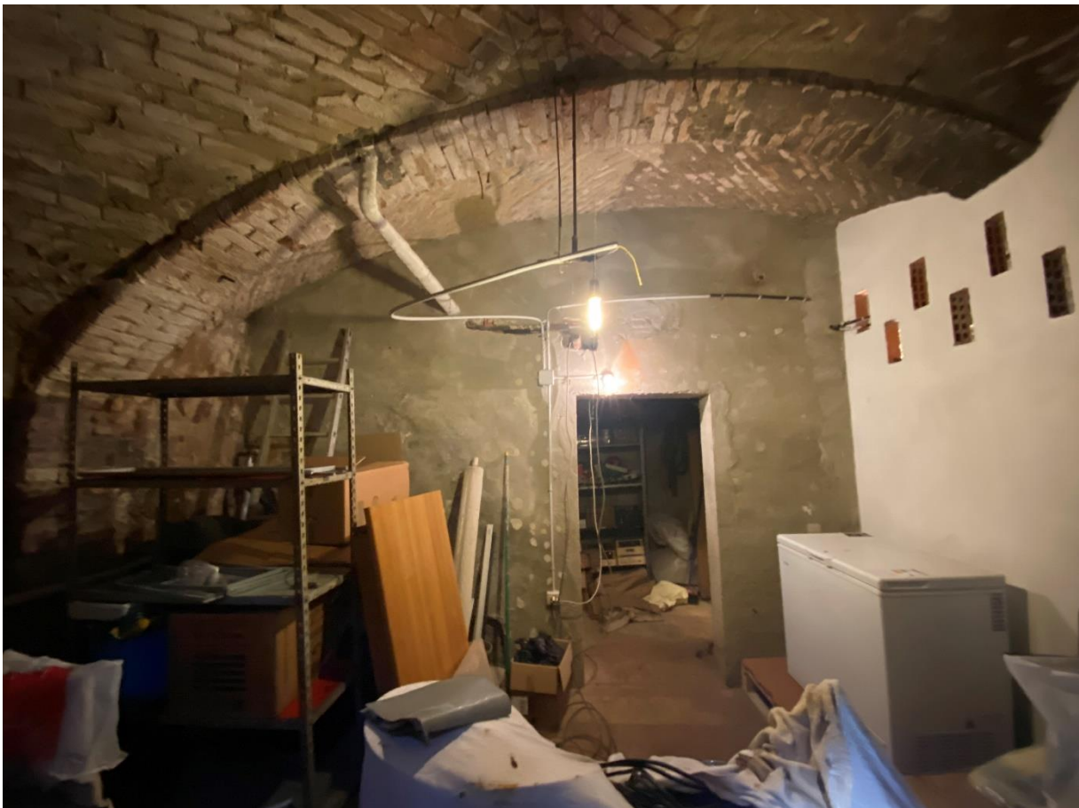
FOTO 20: cantina di pertinenza
