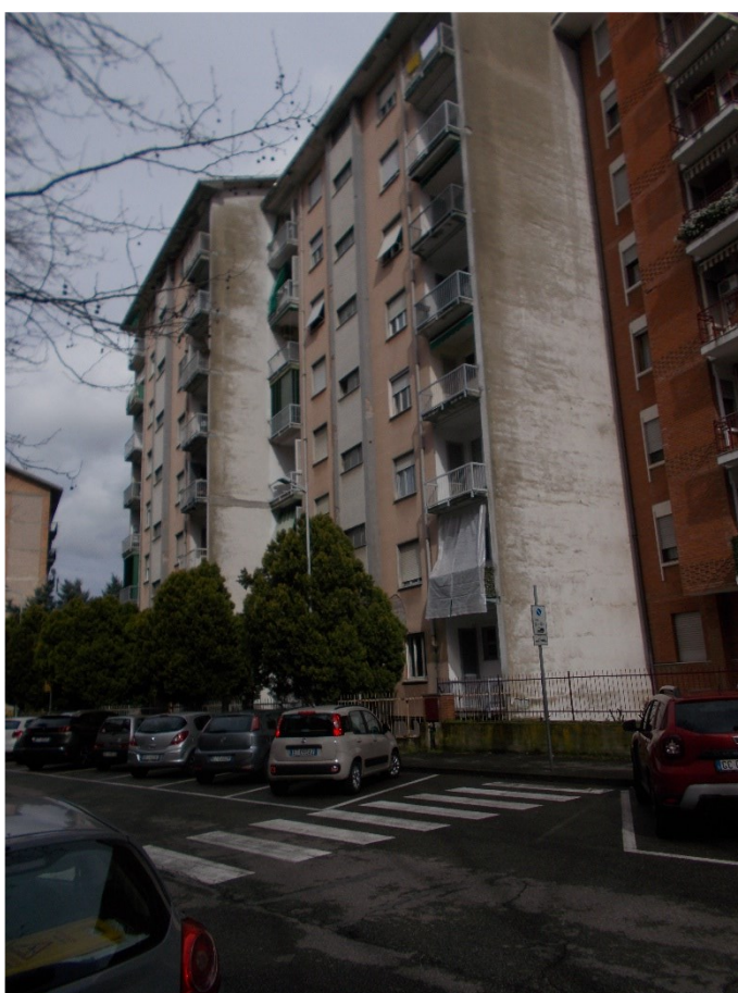
Foto 2. CONDOMINIO VIALE DE GASPERI 16/18 – Particolare prospetto aggettante Viale Alcide de Gasperi
