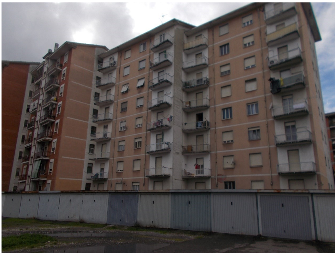
Foto 7. CONDOMINIO VIALE DE GASPERI 16/18 – prospetto aggettante il cortile interno
