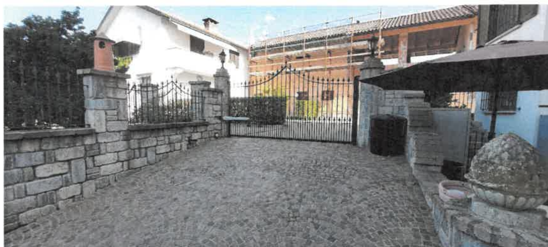
FOTO 6 – Rampa e cancello
