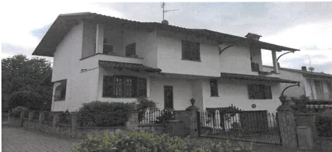
FOTO 4 – Prospetto nord-ovest e accesso carraio
