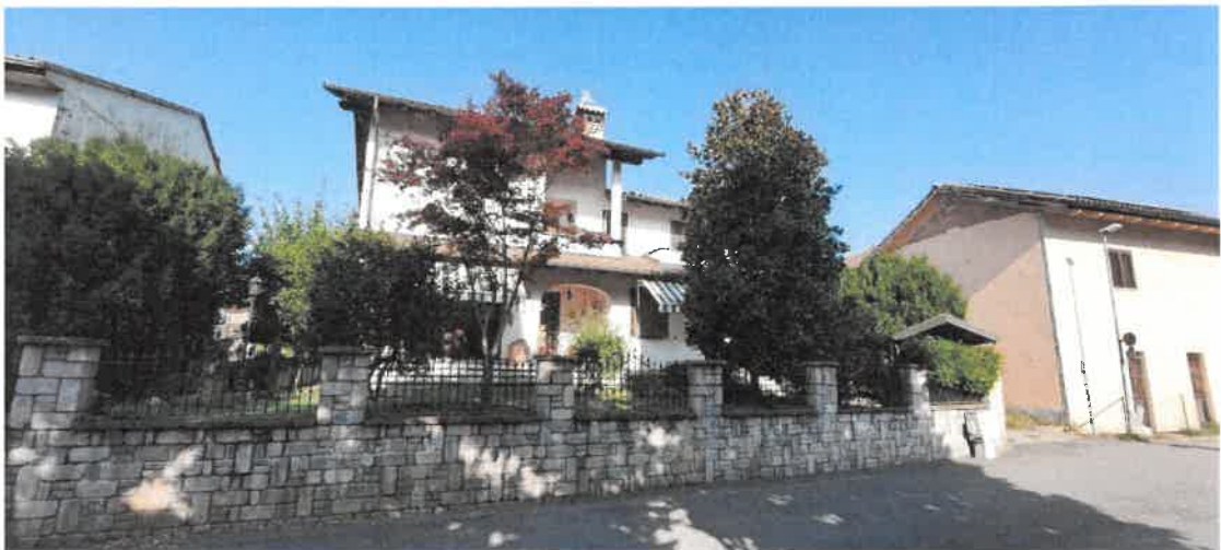
FOTO 2 – Prospetto su Via Leonardo Da Vinci n.4
