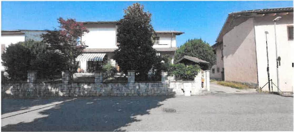
FOTO 1 – Prospetto su Via Leonardo Da Vinci n.4
