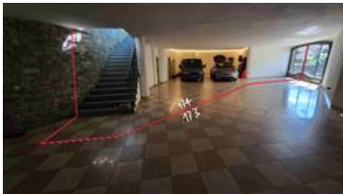
Confini materializzati al piano interrato fra p.ed. 174 (villetta unifamiliare) e p.ed. 173 (maso chiuso)
