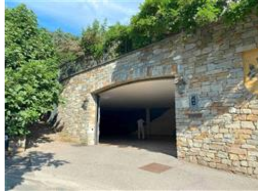
Portone di ingresso al piano interrato / cantina
