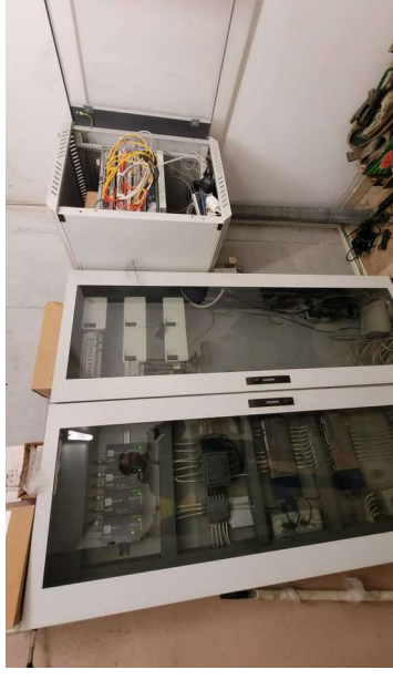
L6_Corpo A_Maso chiuso_01 3. p interrato (8)
