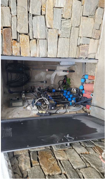
L6_Corpo A_Maso chiuso_04 p. terra (14)
