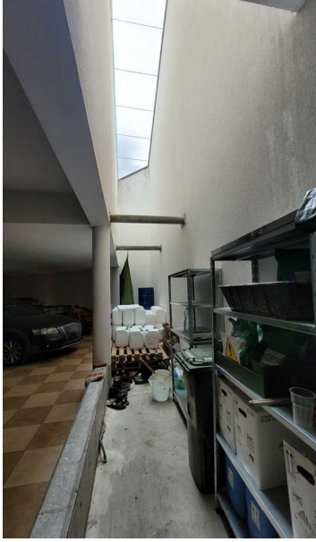
L6_Corpo A_Maso chiuso_01 3. p interrato (19)
