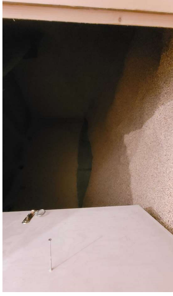
L6_Corpo A_Maso chiuso_01 3. p interrato (13)
