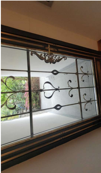
L6_Corpo A_Maso chiuso_03 1. p interrato (9)
