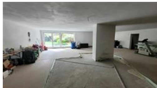
Zona al grezzo (fitnessraum) al 2. piano interrato
