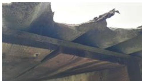
Particolare del tetto in eternit
