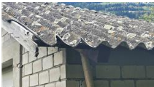
Particolare del tetto in eternit
