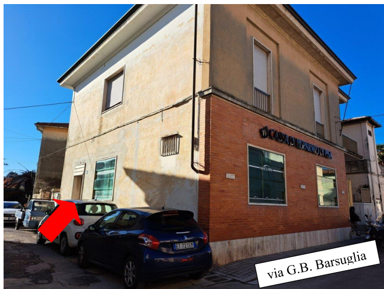
Fig. 2 – Fabbricato comprendente l'immobile oggetto di stima
