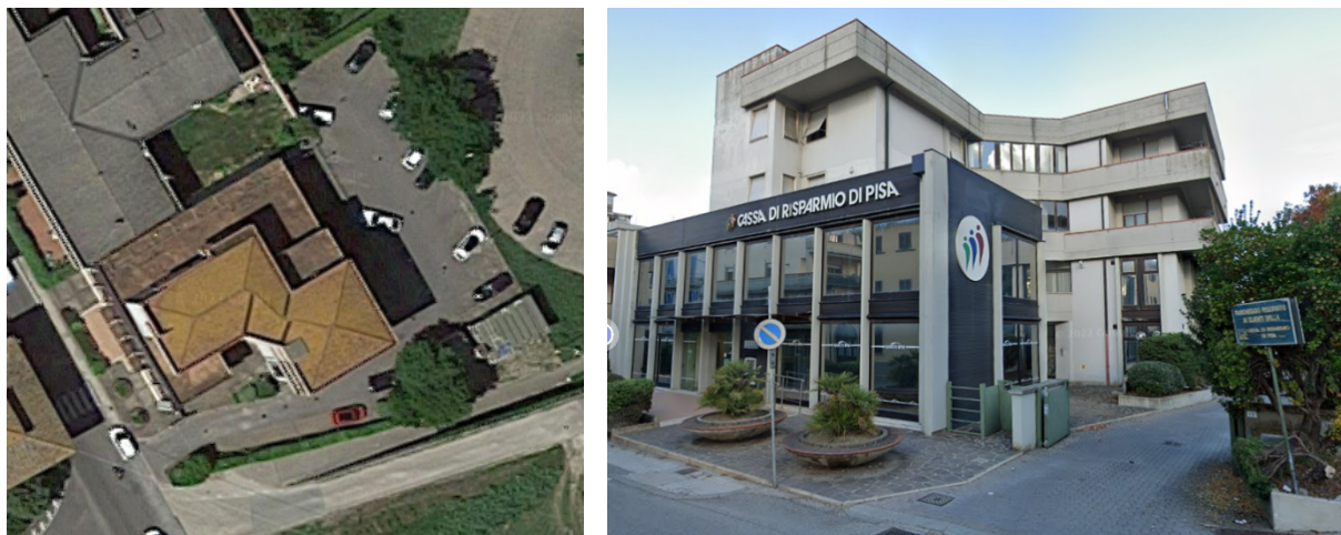
Fig. 2 – Individuazione del fabbricato comprendente gli immobili oggetto di stima
