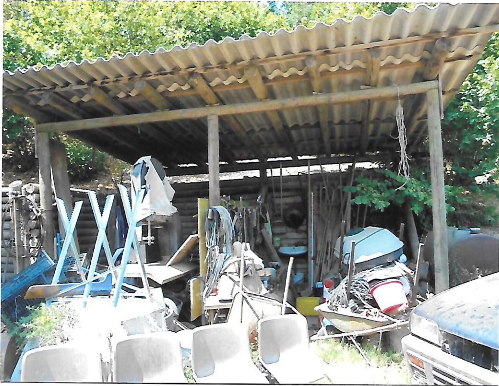
Foto 15 - Tettoia in legno adiacente casa
