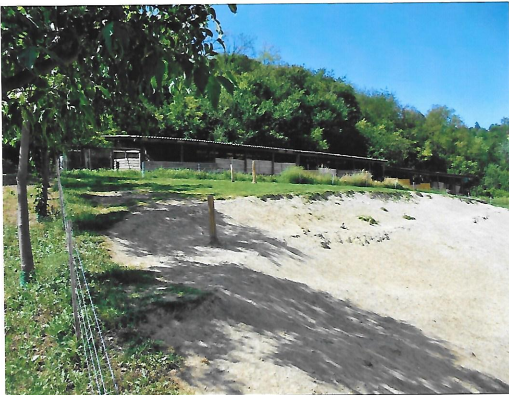
Foto 24 – Tettoia fieno e paglia
