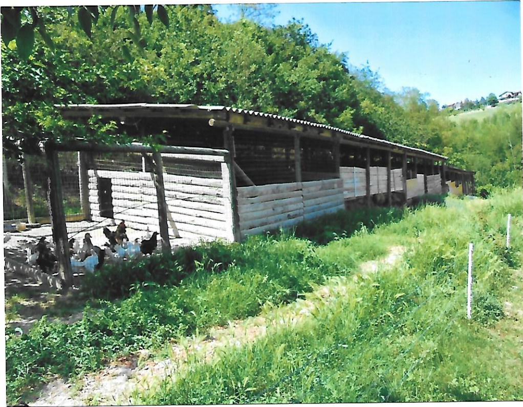
Foto 25 - Tettoia per stoccaggio fieno e paglia
