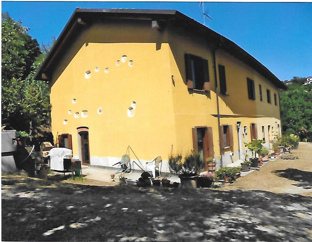
Foto 1 - Casa fianco ovest e prospetto principale
