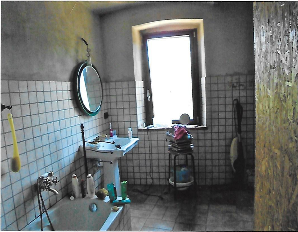
Foto 13 - Casa bagno piano primo
