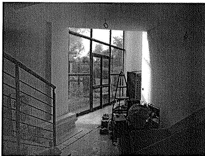
Vista interna accesso all'interno del corpo scala principale
