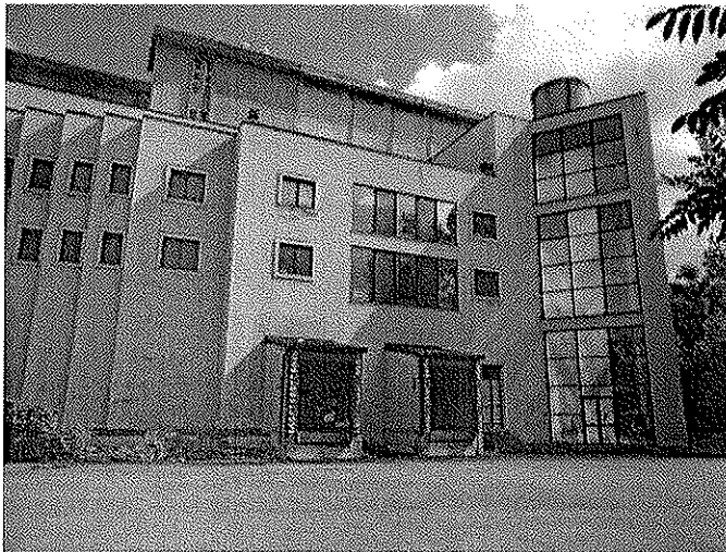
Vista esterna fabbricato
