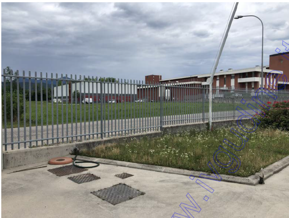
Fotografia A.9 - Particolare recinzione su strada Comunale
