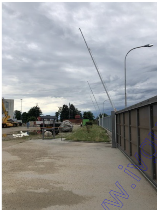
Fotografia A.11 - Particolare cancello carraio
