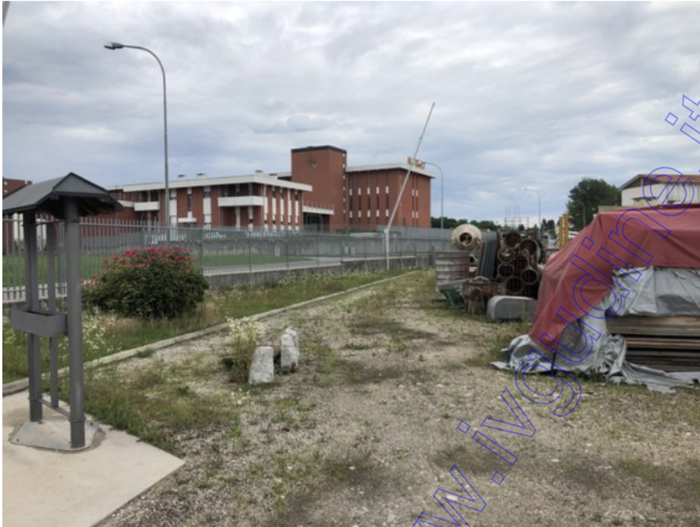
Fotografia A.3 - Particolare piazzale lato nord
