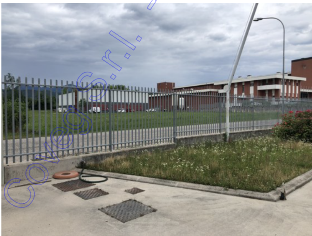
Fotografia A.8 – Particolare recizione lato strada Comunale
