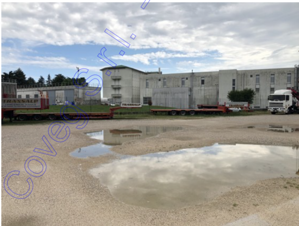
Fotografia A.10 - Piazzale lato sud
