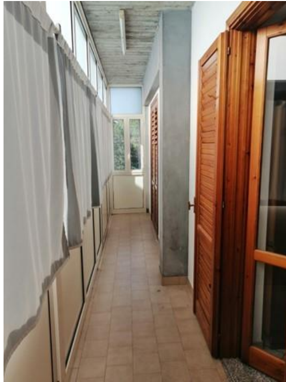
Foto 25 – Altra vista Veranda nel ballatoio lato ovest
