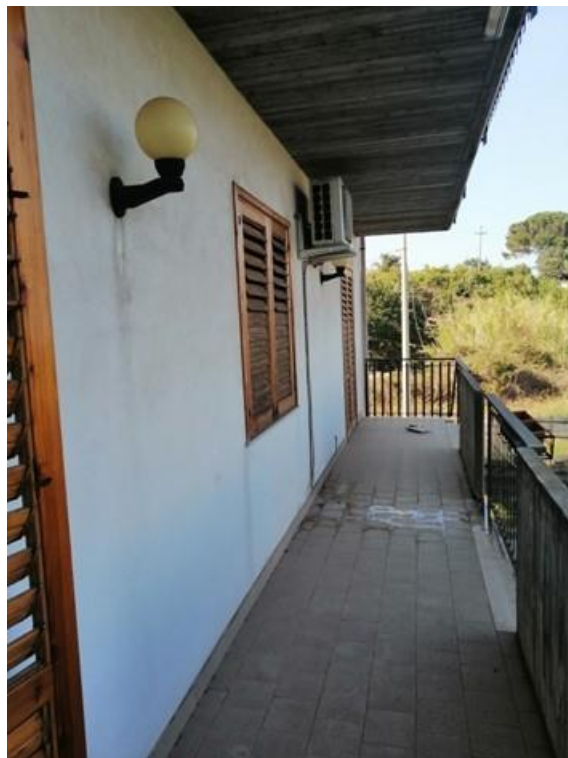
Foto 27 – Ballatoio lato est
