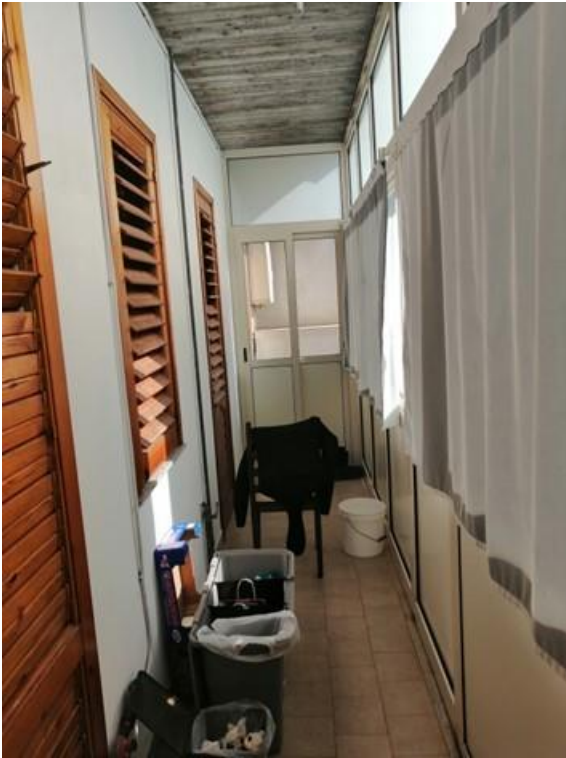
Foto 24 - Veranda nel ballatoio lato ovest
