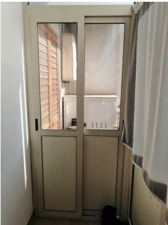
Foto 26 – Altra vista veranda nel ballatoio lato ovest
