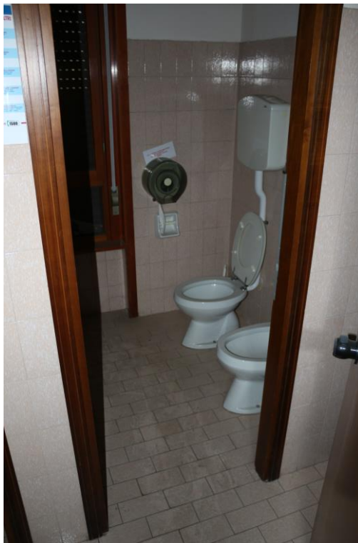
FOTO N°12. - visione interna - PIANO PRIMO
