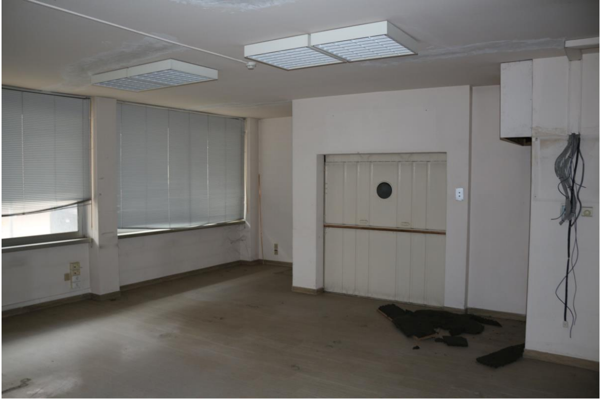
FOTO N°9. - visione interna – PIANO PRIMO
