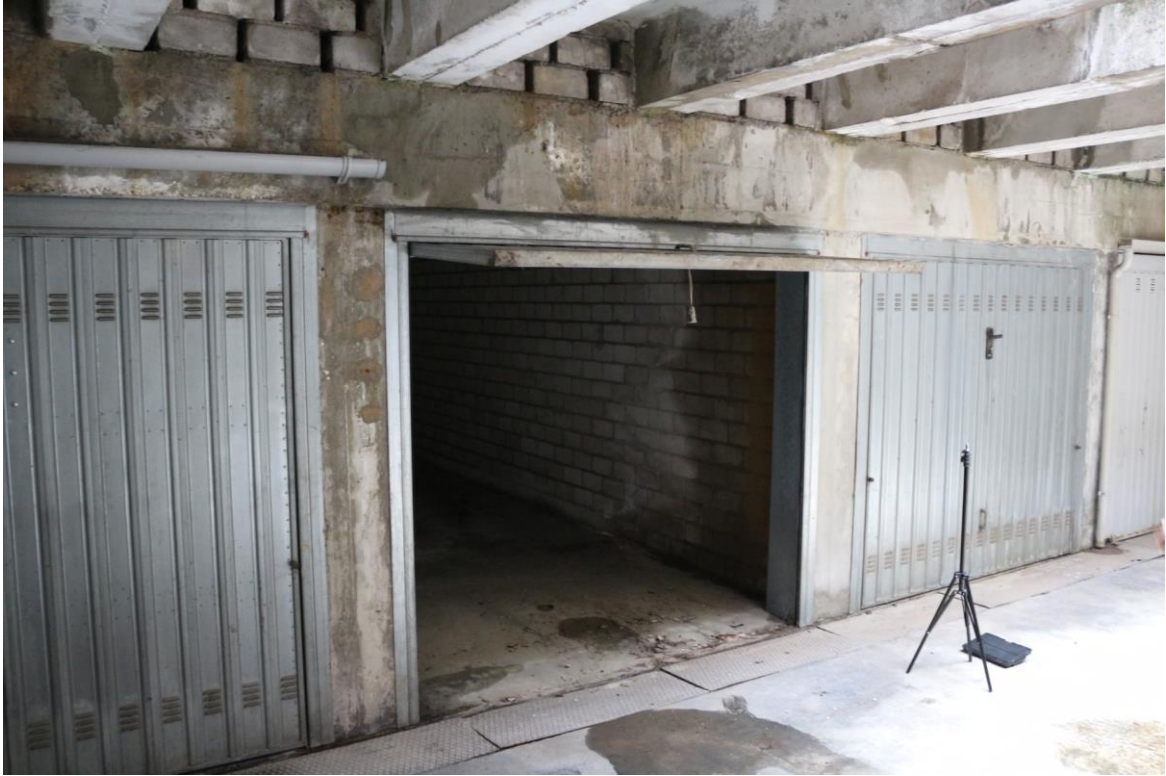
FOTO N°17. - visione garage tipo – PIANO INTERRATO
