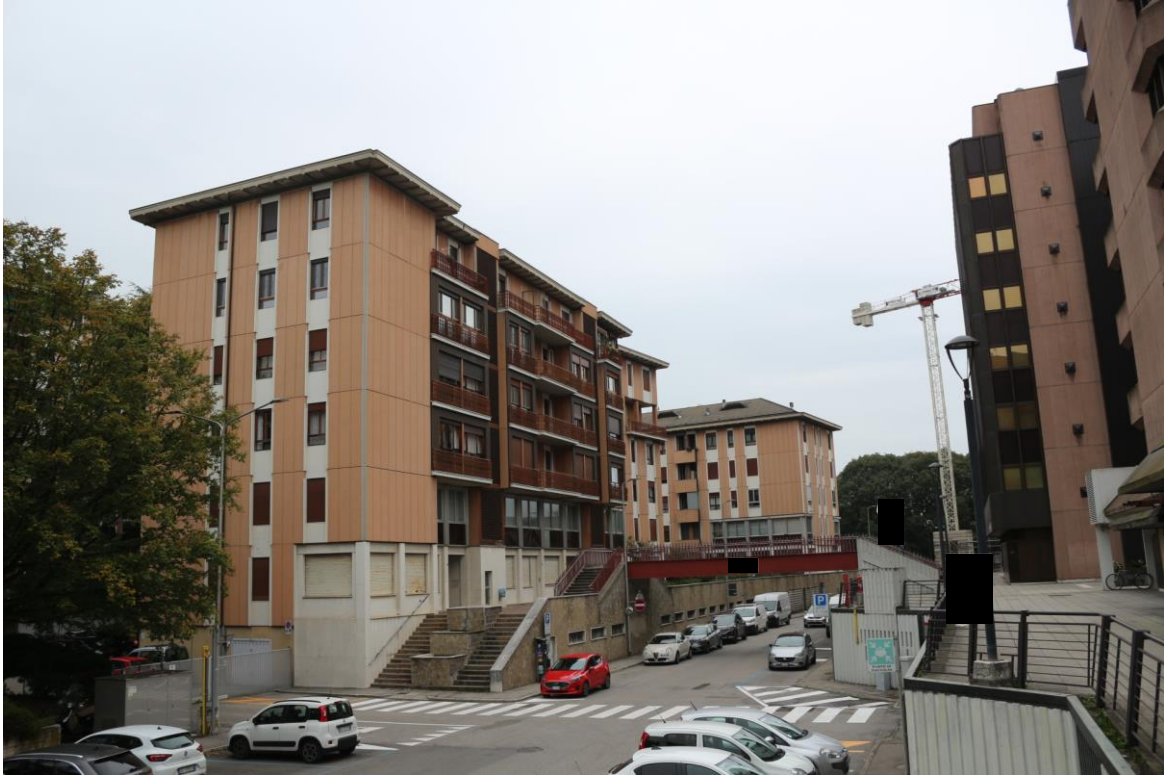
FOTO N°1. - visione esterna fabbricato
