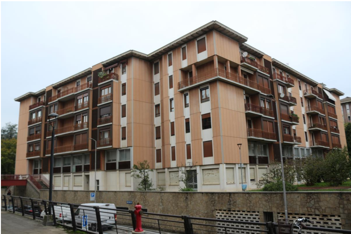
FOTO N°2. - visione esterna fabbricato
