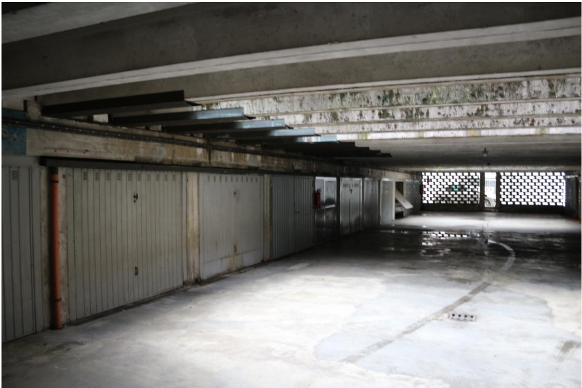
FOTO N°16. - visione area garage e magazzini - PIANO INTERRATO
