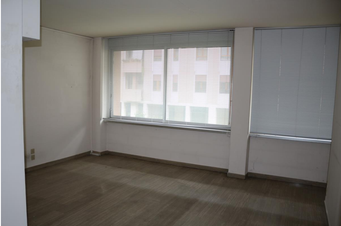
FOTO N°11. - visione interna - PIANO PRIMO
