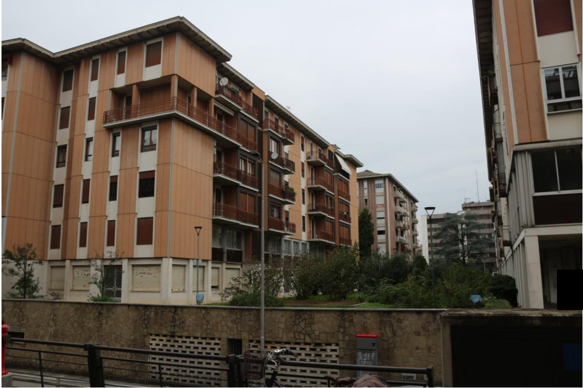
FOTO N°3. - visione esterna fabbricato
