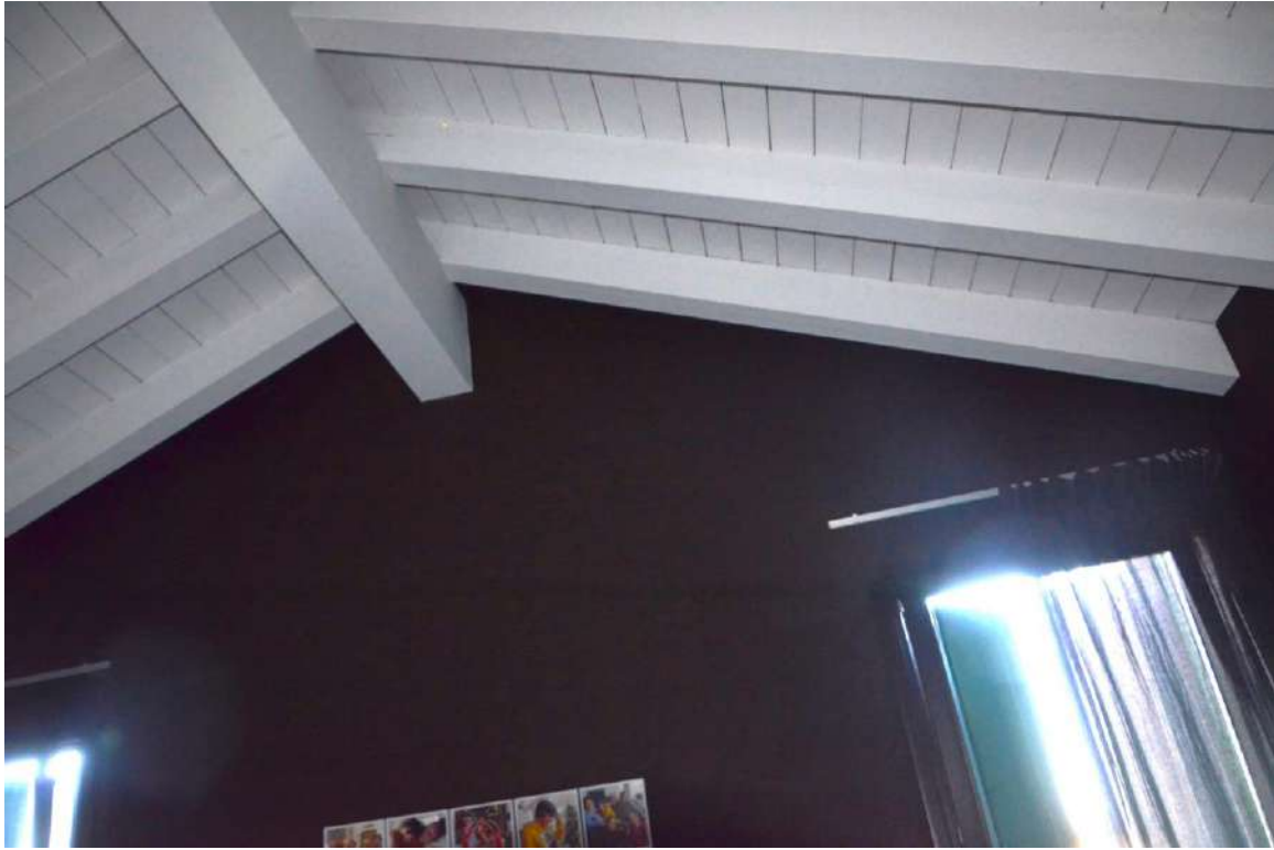
Solaio di copertura piano 3
