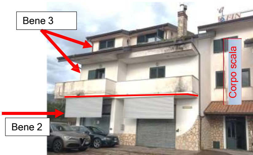
Vista lato ingresso
