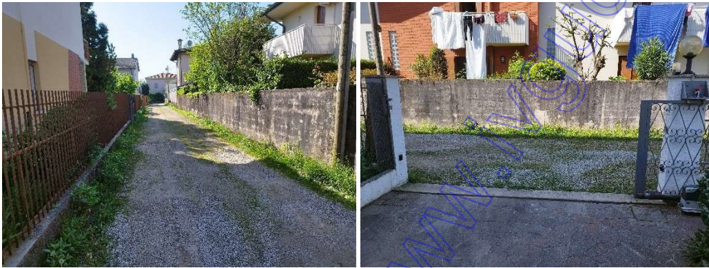
Accesso da viabilità privata e portone carroia
