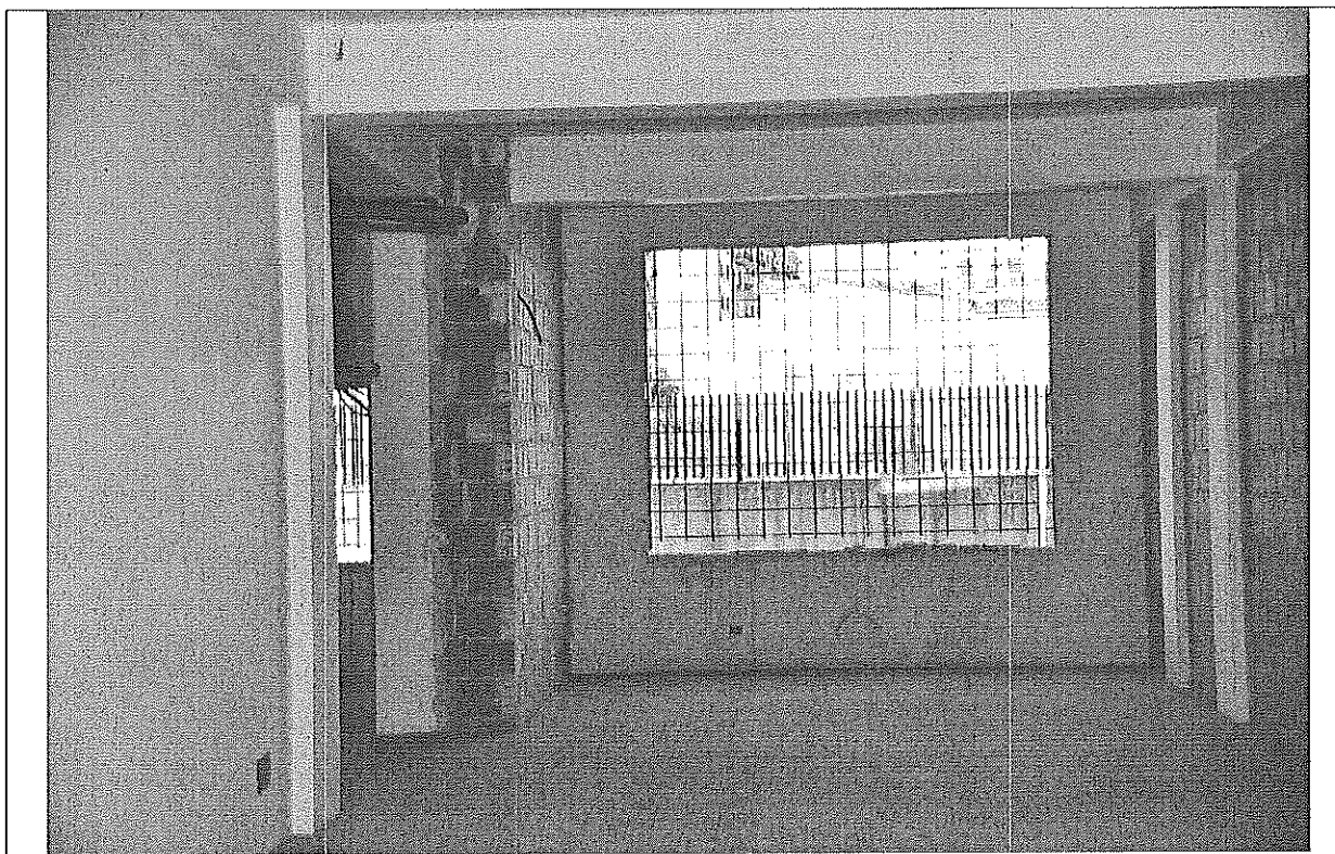
Foto n. 25 – Vista dell'immobile al piano terra sub 2
