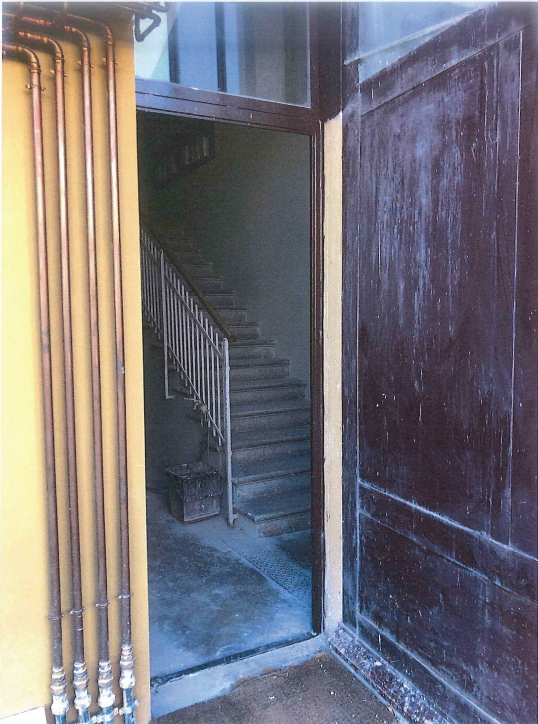
Foto n. 5 – Ingresso esterno dalla zona garage.
