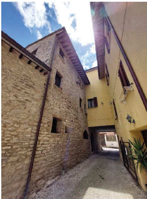
Foto 34 – prospetto fianco sinistro
