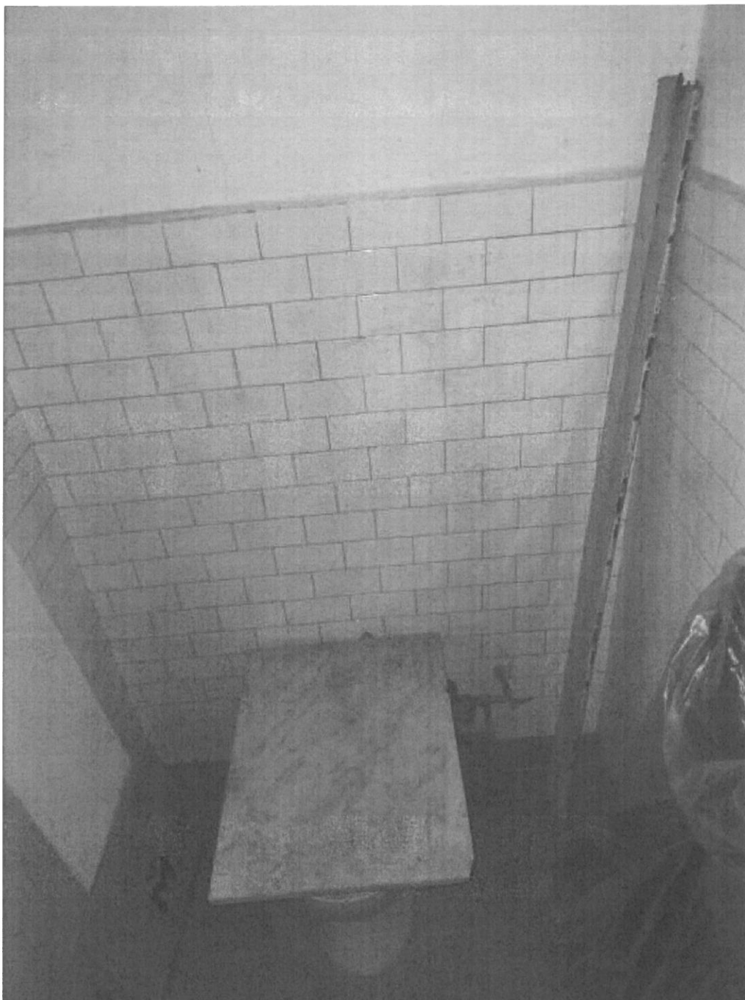
Bagno di servizio su vano scala
